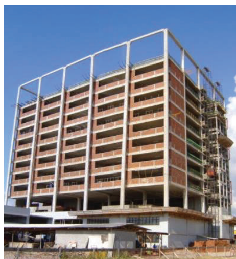
Figura 73: Obra da Universidade Universo em Recife (PE) – 12 pavimentos em estrutura pré-fabricada
