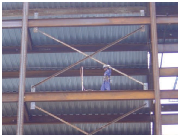
Figura 30: Steel deck aplicado na obra (Imagem: arquivo CBCA)
