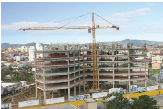
Figura 71: Obra do Edifício Comercial Terra Firme em São José (SC), com 14 pavimentos em sistema híbrido
