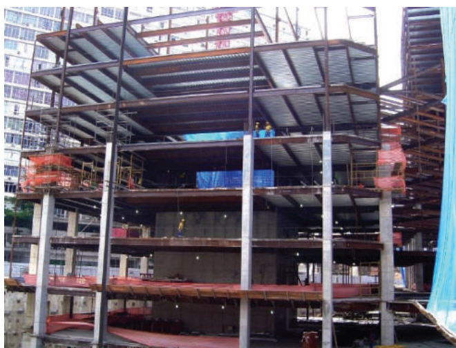
Figura 33: Vista de fachada com os pilares mistos em processo de concretagem (Foto: Ricardo Werneck)
