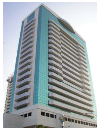
Figura 72: Empreendimento Pátio Dom Luís em Fortaleza (CE), composta de vigas e lajes pré-fabricadas protendidas e pilares moldados no local e torres de 20 e 24 pavimentos
