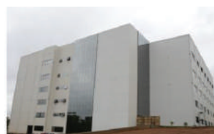
Figura 46: Fachada em light steel framing com vedaç o em Placas Ciment cias (Fonte: Saint-Gobain)
