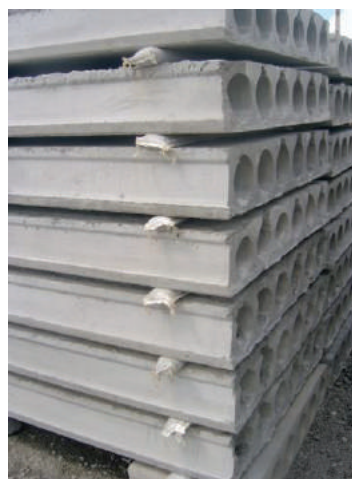
Figura 82: Situações transitórias: armazenamento de lajes alveolares pré-fabricadas
