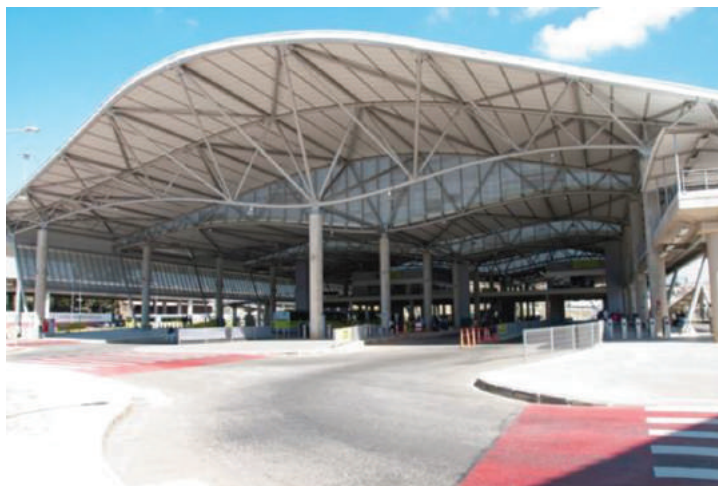
Figura 87: Terminal rodoviário urbano de integração do BRT de Belo Horizonte, em estrutura híbrida, pilares pré-fabricados de concreto e cobertura metálica
