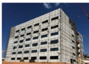
Figura 46: Fachada em light steel framing com vedaç o em Placas Ciment cias (Fonte: Saint-Gobain)
