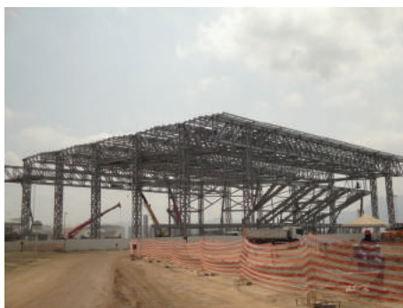
Figura 5: Arena de Handebol estruturada em aço (Parque Olímpico – Rio de Janeiro, Olimpíadas 2016). Foto: Silvia Scalzo.
