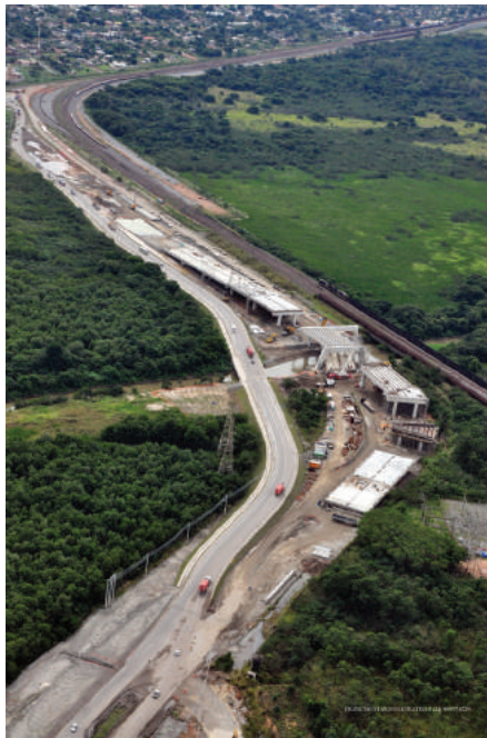
Figura 86: Complexo do Itaguaí no estado do Rio de Janeiro, composto por uma ponte ferroviária, uma ponte e dois viadutos rodoviários, todos em estrutura pré-fabricada de concreto
