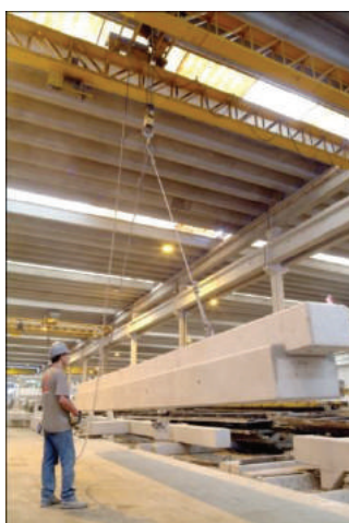
Figura 81: Situações transitórias de projeto e fabricação – manuseio e içamento de viga pré-fabricada
