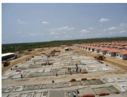
Figura 99: Processo de fabricação no canteiro de obras. (Fonte: Olé Casas, 2015)
