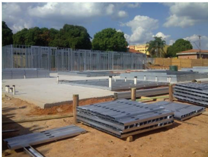
Figura 49: Sistema stick (Fonte: Saint-Gobain)
