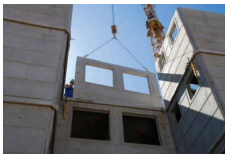
Figura 76: Montagem de painéis em edifício residencial – Condomínio Piemonte, em 2008 – Belo Horizonte (MG)
