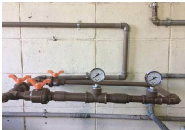
(Figura 9- Tubo de Venturi)
