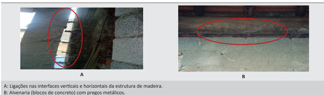
Figura 6. Edificação da residência E (b).
