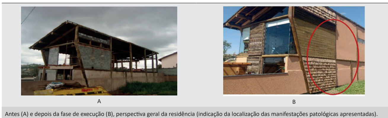
Figura 8. Edificação da residência E (d).
