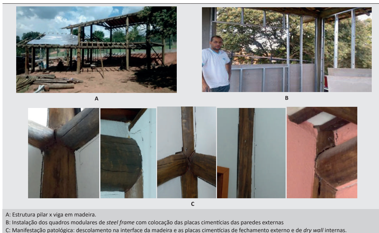
Figura 9. Edificação residência F (a).
