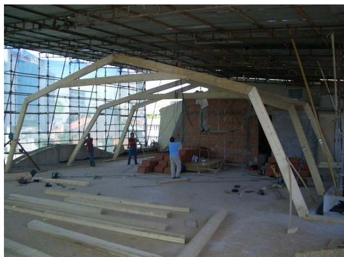
Figura 20-Estrutura dos pórticos e pavimento da cobertura (Costa, 2010)
