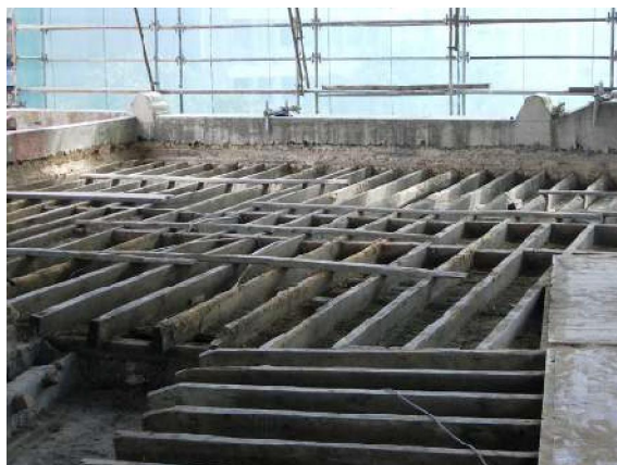
Figura 14- Vigamento de madeira do 5º andar (Costa, 2010)
