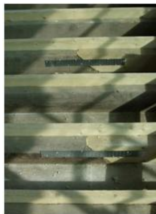
Figura 19-Ligadores metálicos usados nas emendas (Costa, 2010)
