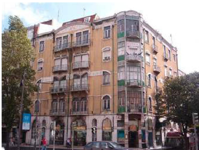
Figura 11-Fachada do edifício antes da reabilitação (Costa, 2010)
