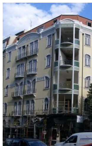
Figura 44- Funis e tubos de queda (Costa, 2010)
