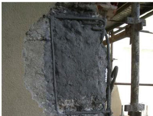
Figura 22-Reparação da estrutura de betão armado (Costa, 2010)
