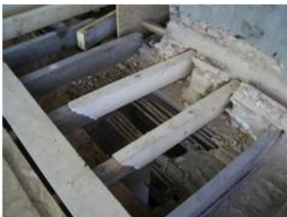
Figura 18-Emendas das vigas que apoiam nos frechais (Costa, 2010)
