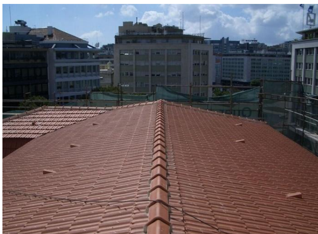
Figura 33- Revestimento da cobertura a telha marseilha (Costa, 2010)
