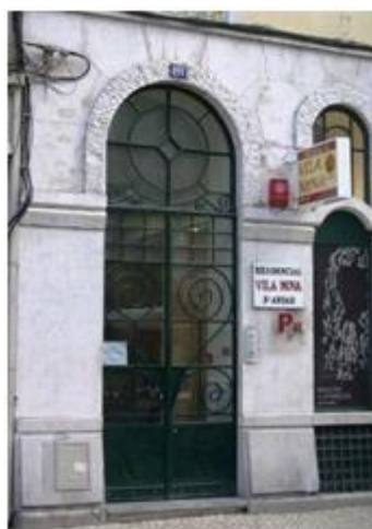
Figura 42- Porta Original de Ferro (Costa, 2010)
