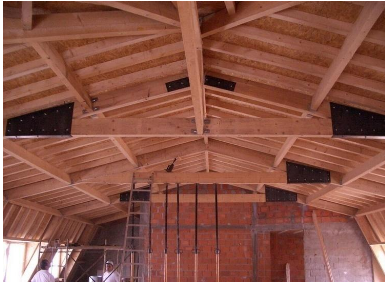
Figura 21- Fixações nos nós da estrutura da cobertura (Costa, 2010)
