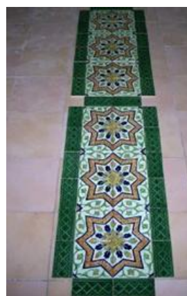
Figura 35- Ensaio para aplicação dos novos azulejos (Costa, 2010)
