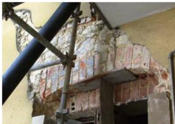
Figura 24- Picagem do reboco ao suporte (Costa, 2010)
