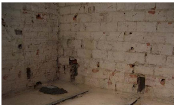
Figura 15- Paredes interiores (Costa, 2010)
