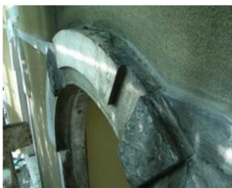
Figura 36- Cantaria do vão da janela (Costa, 2010)
