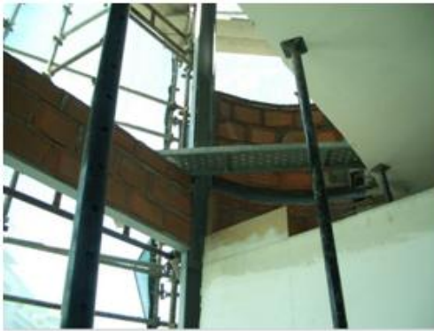
Figura 26- Reconstrução dos panos de alvenaria (Costa, 2010)
