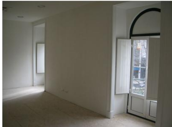
Figura 39- Caixilharia e portadas de alumínio e bandeira com chapa branca (Costa, 2010)
