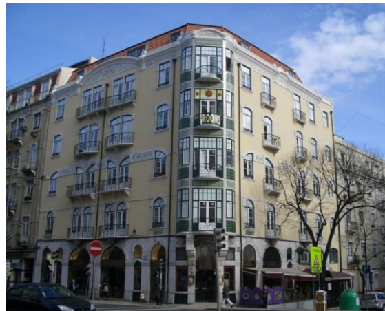
Figura 32- Pintura da fachada após ação de reabilitação (Costa, 2010)
