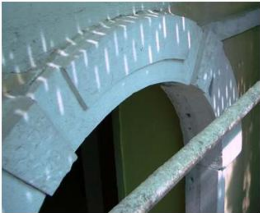
Figura 38- Cantaria após a limpeza (Costa, 2010)
