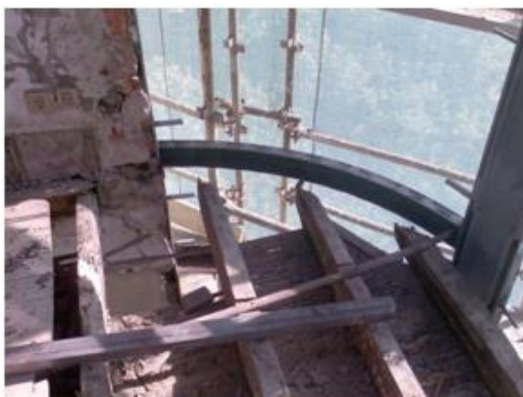
Figura 25-Exposição das vigas e estrutura metálica (Costa, 2010)
