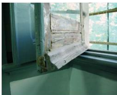
Figura 37- Caixilharia de madeira original (Costa, 2010)
