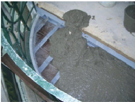
Figura 28- Laje aligeirada das varandas_ fase de betonagem (Costa, 2010)
