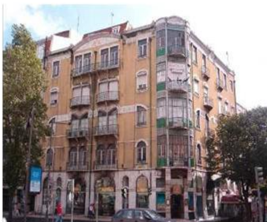
Figura 31- Pintura da fachada antes da intervenção de reabilitação (Costa, 2010)
