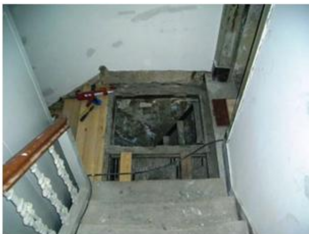
Figura 45- Acesso á casa das máquinas (Costa, 2010)
