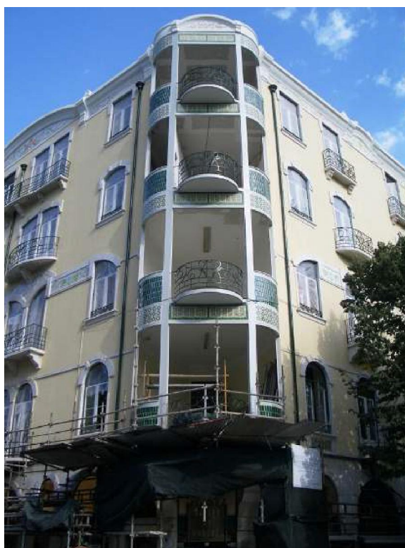
Figura 13-Estrutura do vão do gaveto, após fase da obra de reparação (Costa, 2010)
