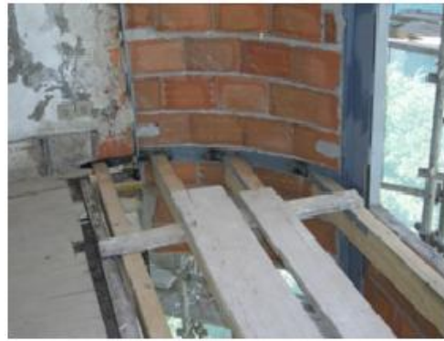
Figura 27-Substituição do vigamento de madeira (Costa, 2010)
