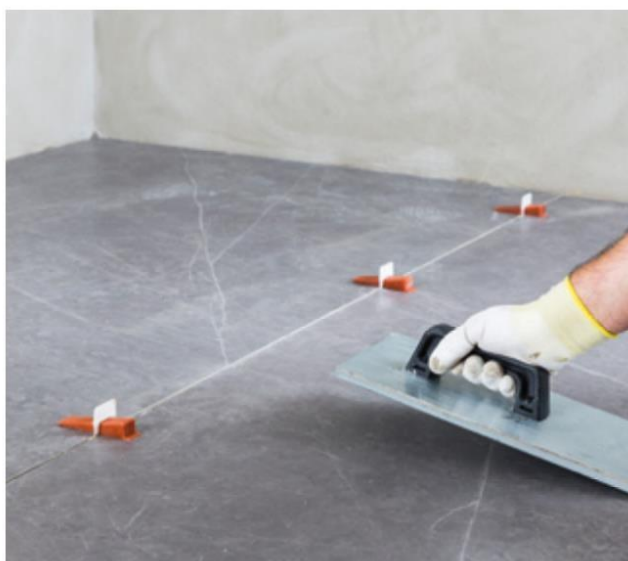
Простукивание плитки вручную или с помощью вибропанели
