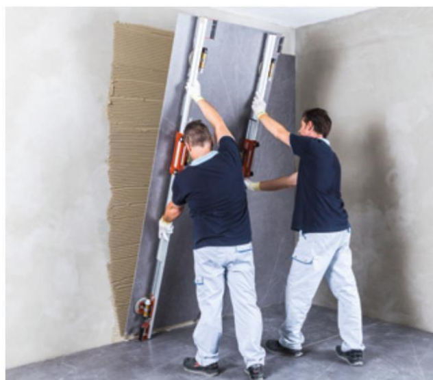
Укладка плитки на стену
