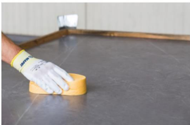
Очистка поверхности плитки
