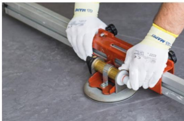
Использование присоски с насосом
