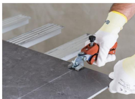
Разламывание плитки с помощью щипцов для надлома
