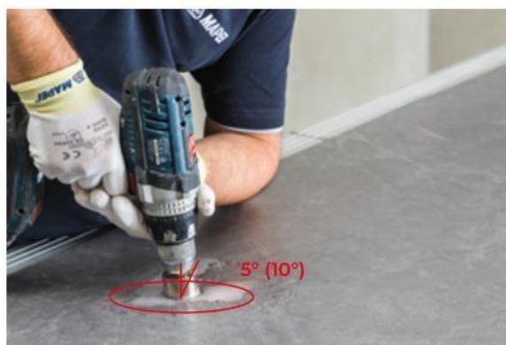
Порядок действий по созданию круглого отверстия
