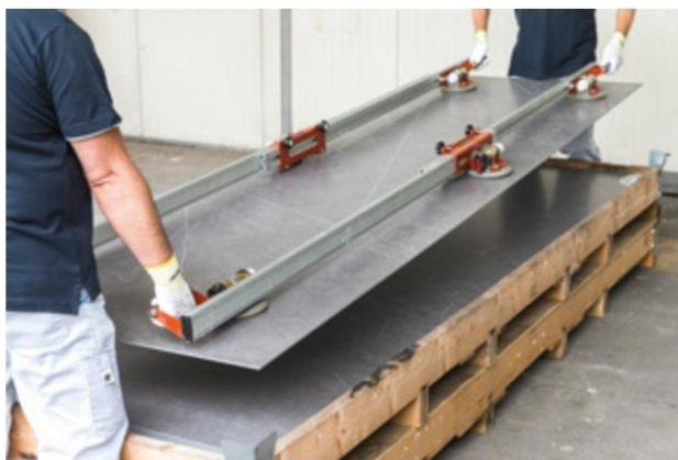
Правильное перемещение плитки
