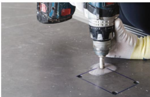
Порядок действий по созданию прямоугольного отверстия
