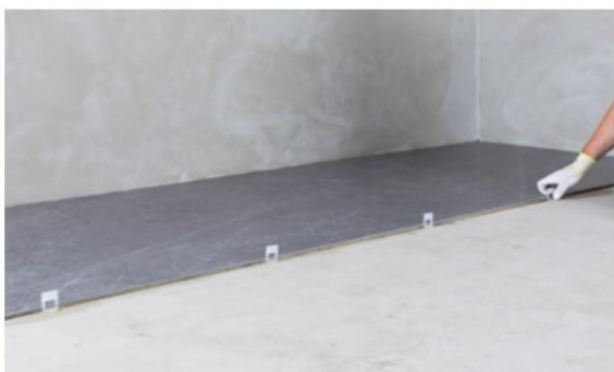
Установка разделителей в требуемое положение
