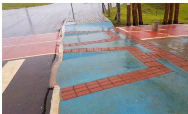
Figura 14: Calçadas com piso podotátil e rebaixamento correto na zona B.
