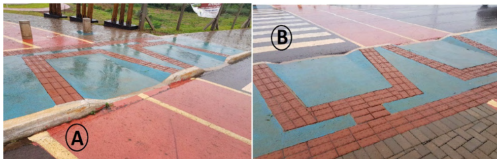
Figura 13: Calçadas com piso podotátil e rebaixamento.
