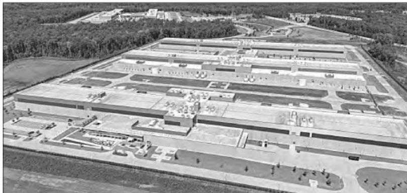
▲ Instalaciones del centro de datos ubicado en Georgia. Foto Ap
