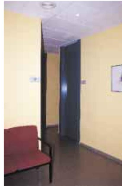
Fig.1. Techo modular apoyado sobre perfiles metálicos.
