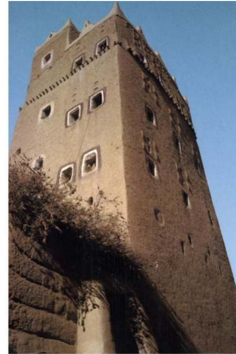
Figura 70. Casa-torre de Sannaa, Iêmen. Edificação tradicional feita em alvenaria de tijolos de adobe, com vários pisos internos estruturados em madeira, e detalhes em pedra nas janelas. Essa arquitetura preserva características construtivas e espaciais milenares bastante semelhantes às que podem ser percebidas na “Casa da Alma” da Figura 69. Referência iconográfica: WILDUNG, 1997.
