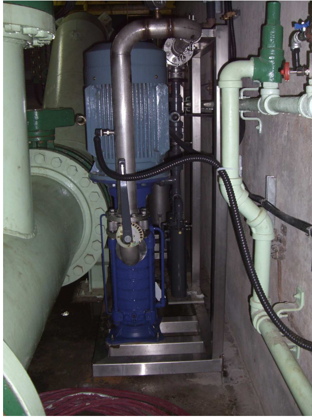
(a) Vista geral do conjunto.
