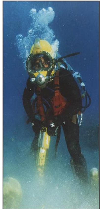
Figura 6-4. Buceo de Construcción Subacuática.
