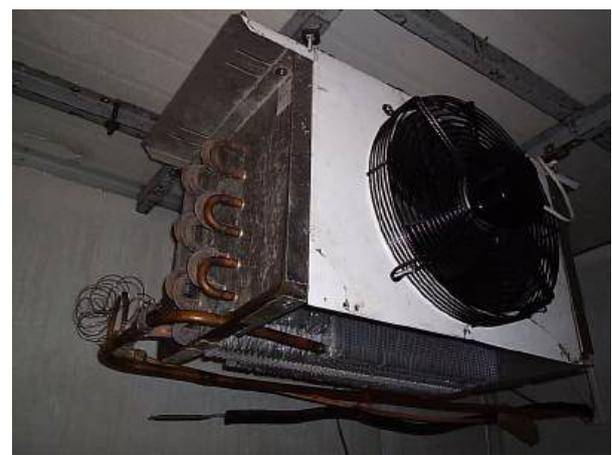
Evaporador de serpentín aleteado y convección forzada para baja temperatura, sin bandeja de condensados.
