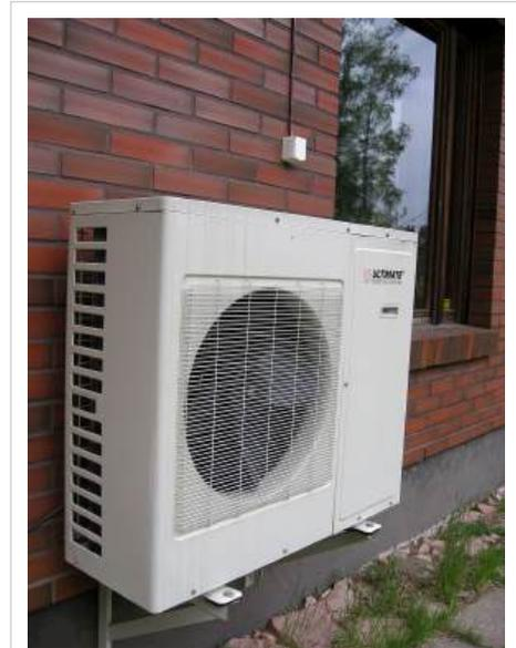
Exterior de un sistema de aire acondicionado moderno (Unidad dividida o tipo "split").
