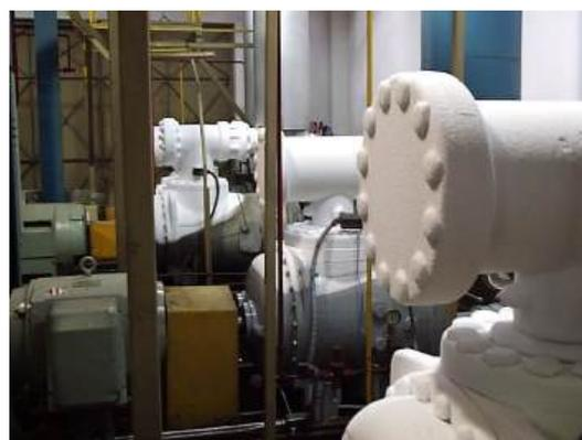
Compresor (máquina) Compresores de tornillo para amoníaco.
