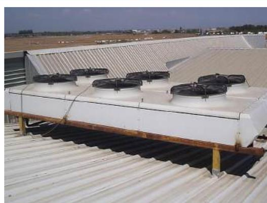
Condensador (termodinámica) Condensadores industriales enfriados por aire para R22.
