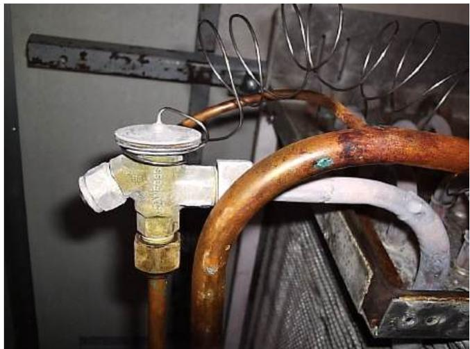
Válvula de expansión termostática VETX para R22 Danfoss TEX2 instalada en evaporador frigorífico de expansión seca.
