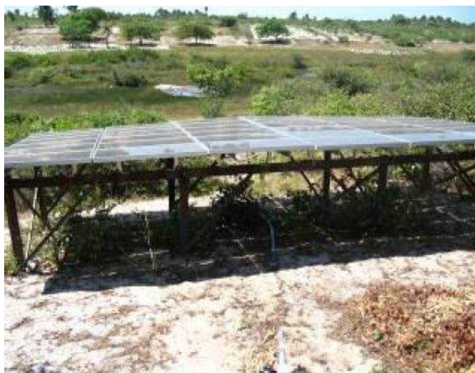
Figura A3.2 – Gerador fotovoltaico do sistema de Bom Jesus. Fonte: (MORALES, 2011).
