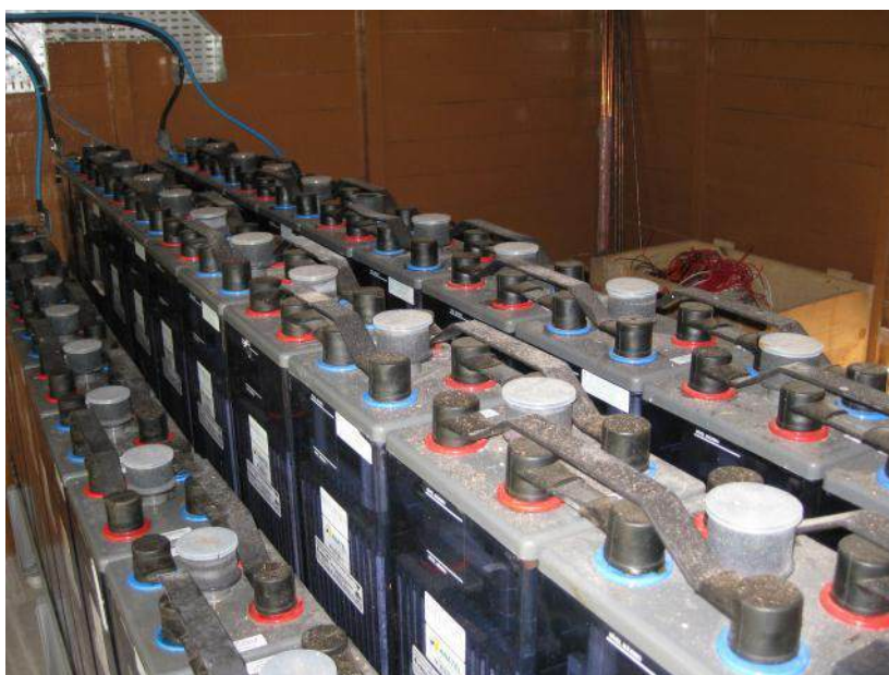
Figura 7.23 – Banco de baterias em MIGDI da Celpa, na Ilha de Araras (Marajó-PA) (Foto cedida pela CELPA).
