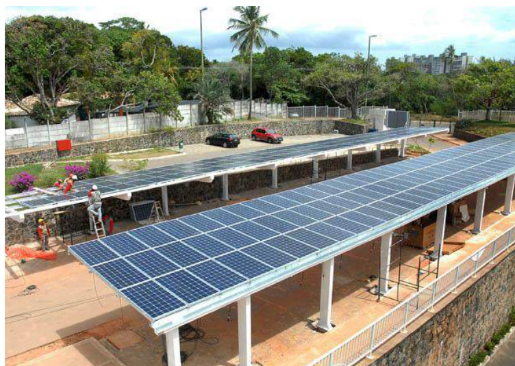
Figura A3.16 – Sistema fotovoltaico instalado na cobertura do estacionamento em Pituaçu. Fonte: (AMERICA DO SOL, 2012).
