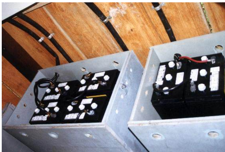
Figura 7.19 – Vista de baterias no interior de uma caixa especialmente construída para seu acondicionamento (Foto cedida pelo LSF-IEE/USP).
