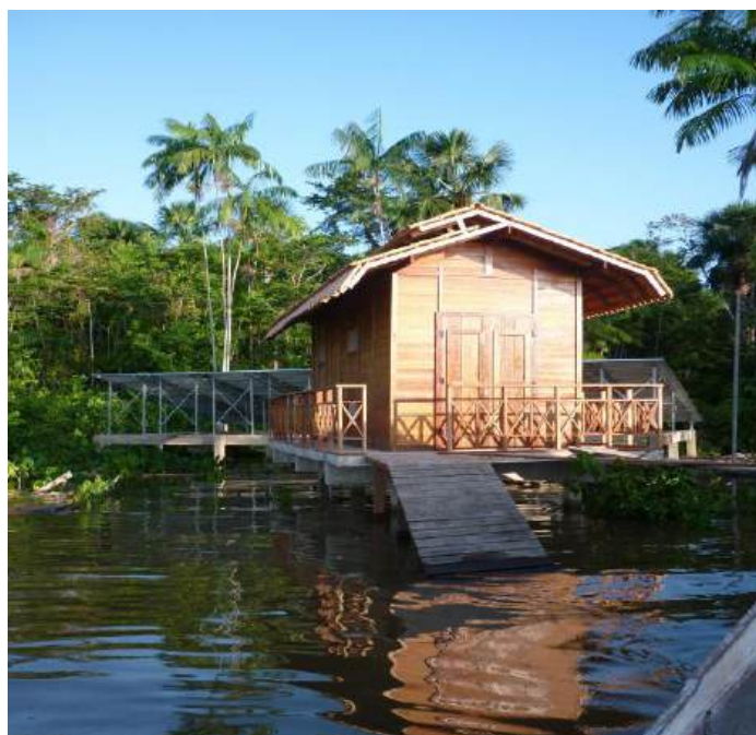
Figura 7.27 – Exemplo de edificação em madeira para instalação de banco de baterias, equipamentos de condicionamento de potência e de proteção - MIGDI da Ilha de Araras, Pará (Foto cedida pela CELPA).
