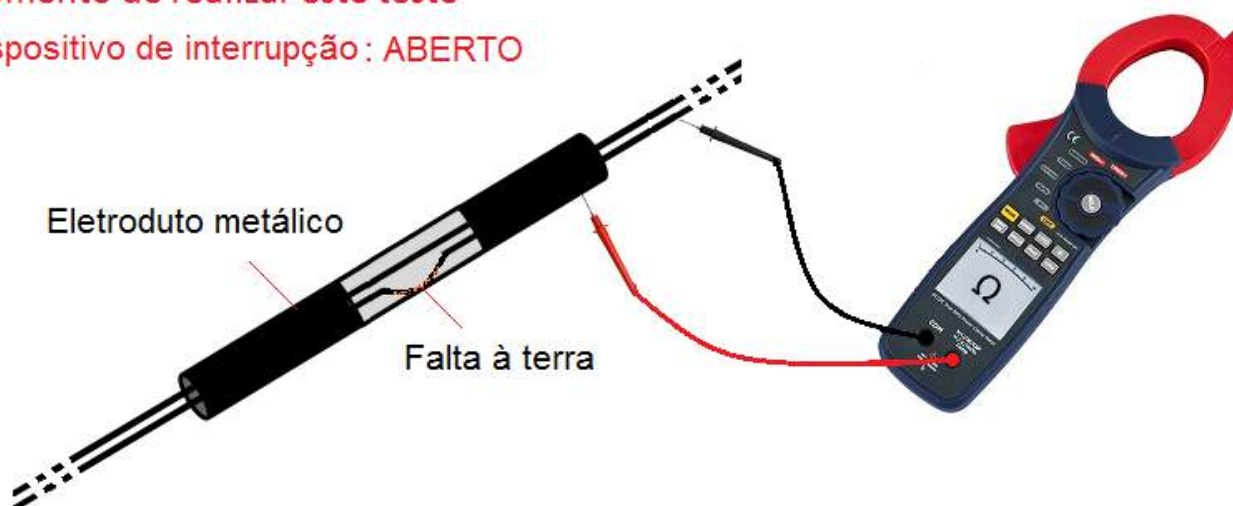
Figura 8.18- Detectando uma falta à terra.
