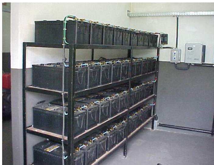
Figura 7.22 – Armário de baterias (Foto cedida pelo GEDAE/UFPa).
