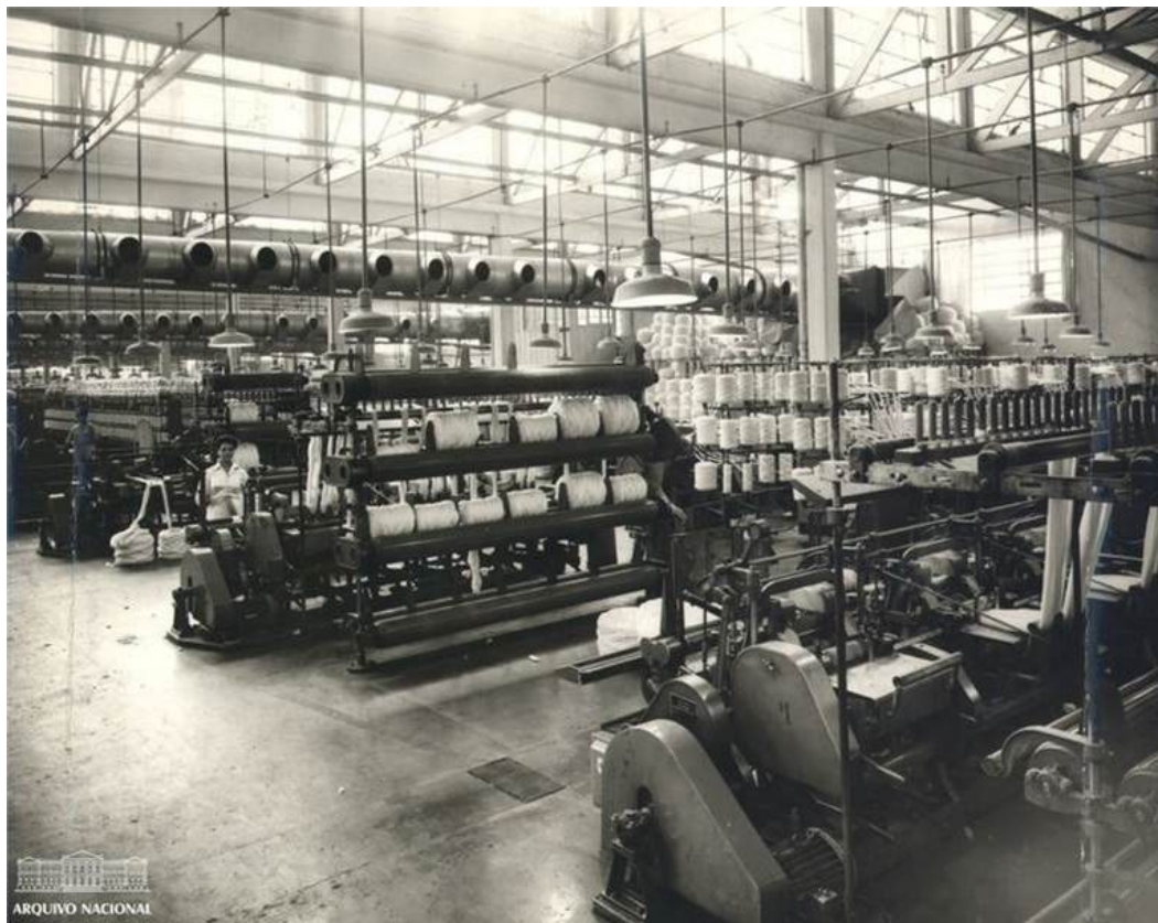
Vista interna do Lanifício Minerva - década de 1940. Fonte: Facebook do Cotonifício Guilherme Giorgi S/A.
