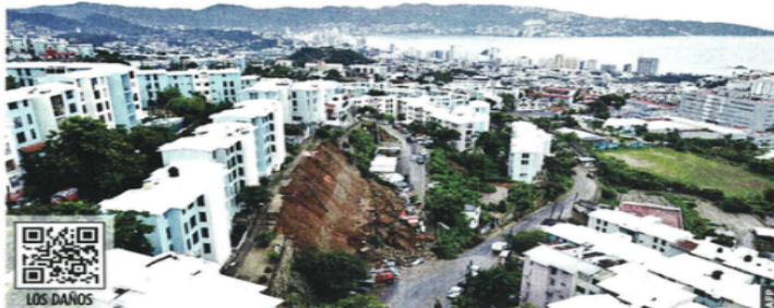
Edificios en Acapulco han quedado en riesgo de colapso, a causa de los deslizamientos.
