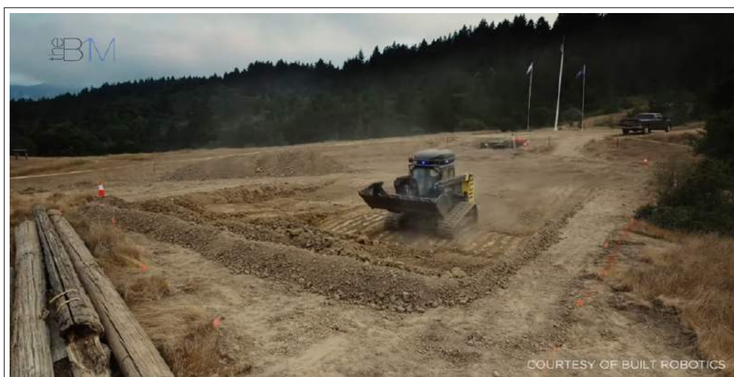
Figura 7.9: Serviço automatizado de terraplenagem.
