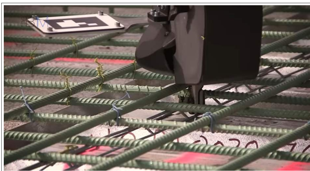
Figura 7.7: Execução de amarração de armadura de laje com robô.
