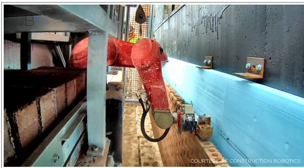
Figura 7.6: Assentamento de alvenaria com robô.
