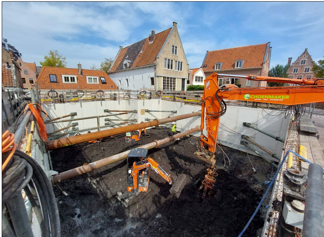
Afb 30 Het uitgraven van de betonnen afzinkkelder voor de nieuwbouw Venidse 2. De grond wordt met een graafmachine met happer uit de bouwput gehaald en in een container op een ponton in het water gestort.
