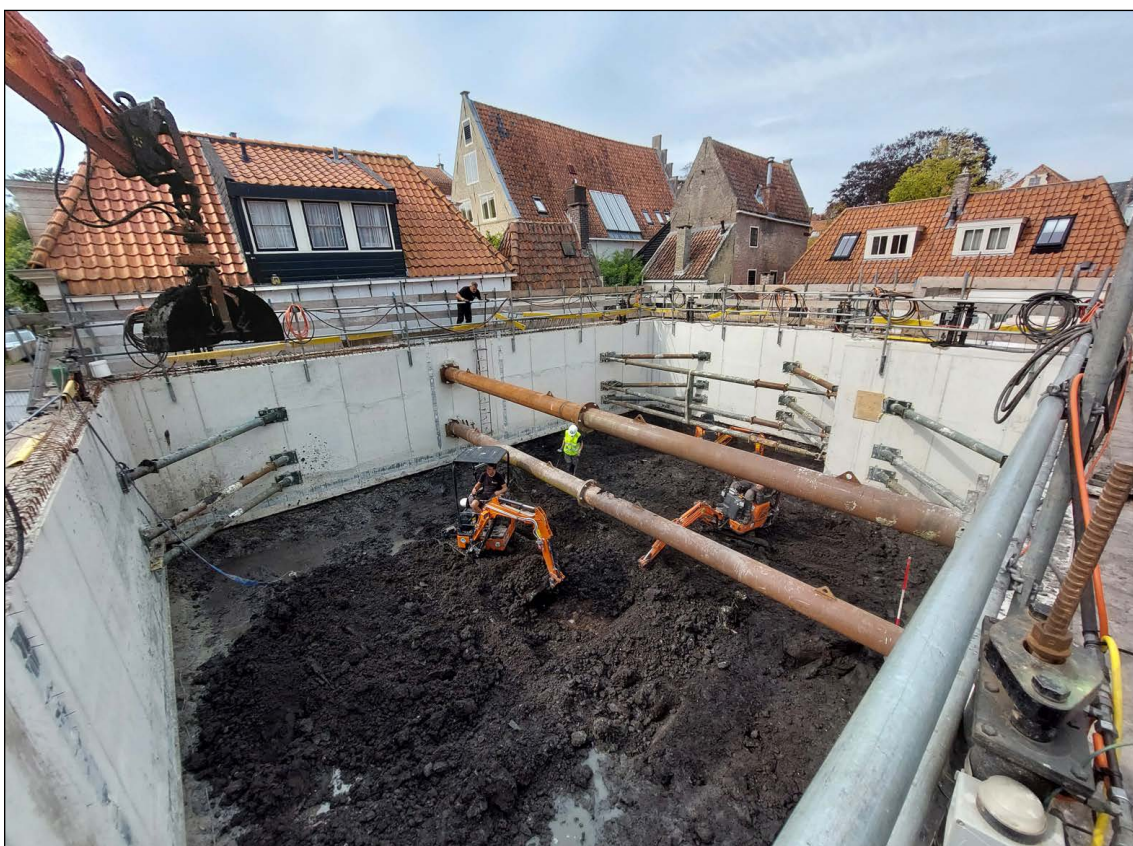
Afb 29 Het uitgraven van de betonnen afzinkkelder voor de nieuwbouw Venidse 2.
