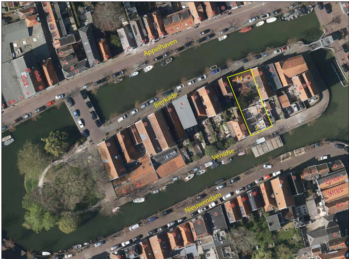
Afb 3.1 Luchtfoto tijdens de bouw van Venidse 2, in 2021. De Bierkade en het Venidse liggen op een eiland in de haven, omringd door het water van de Appelhaven, de Nieuwendam en de Korenmarkt. Dit volledige eiland heette in het verleden 'het Venidse'.
