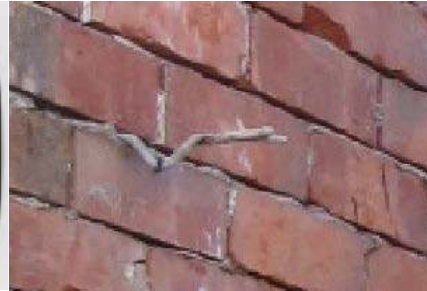
(d) V-drip flat fishtailed wall ties
