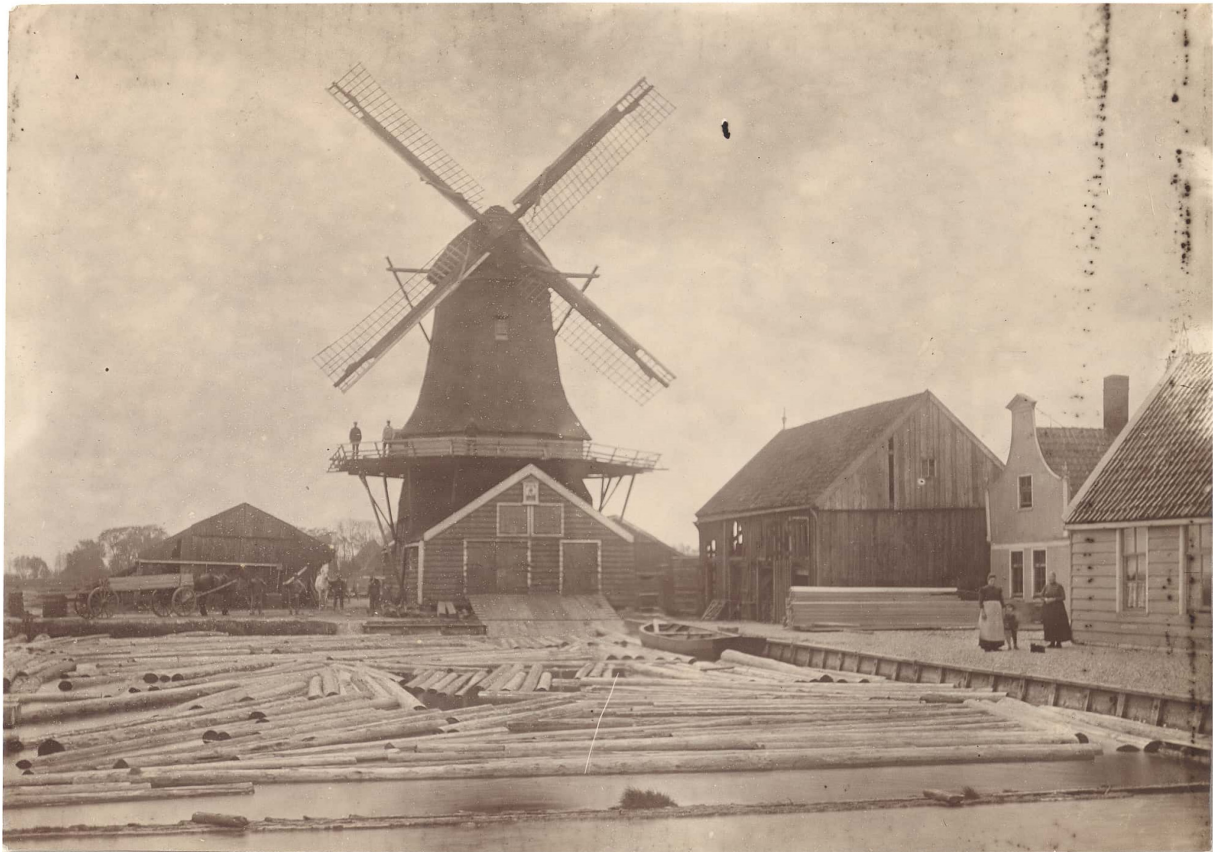
De houtzaagmolen gezien vanuit het noorden, met op de voorgrond het balkengat en de helling. Rechts beide woonhuizen en een droogschuur. Collectie Westfries Archief. Foto 1890.
