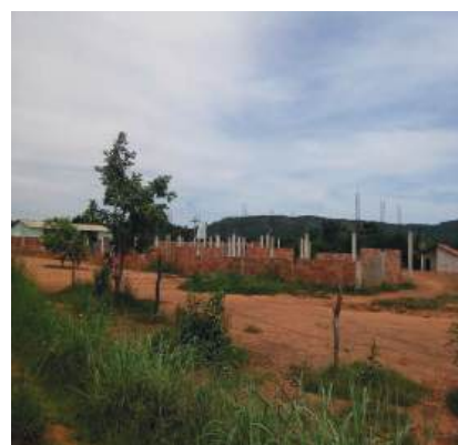
Foto 03. Construção da futura escola da comunidade Malhadinha.
