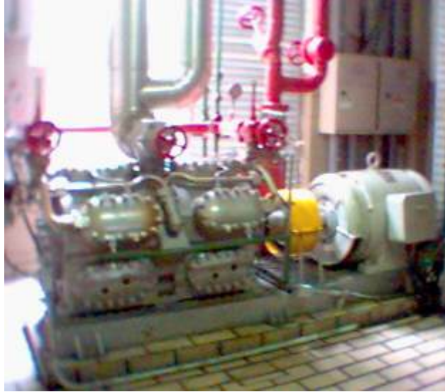
Figura: 2.02 - Compressor alternativo Aberto – Sabroe 12/100
