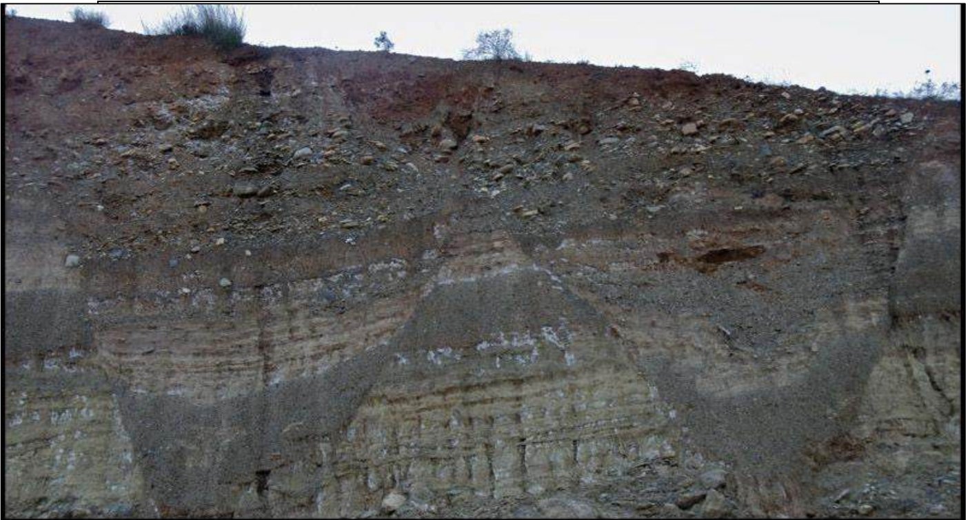
Fallas en Alhucemas (Marruecos) fosilizadas por materiales detríticos gruesos, sin manifestación geomorfológica
