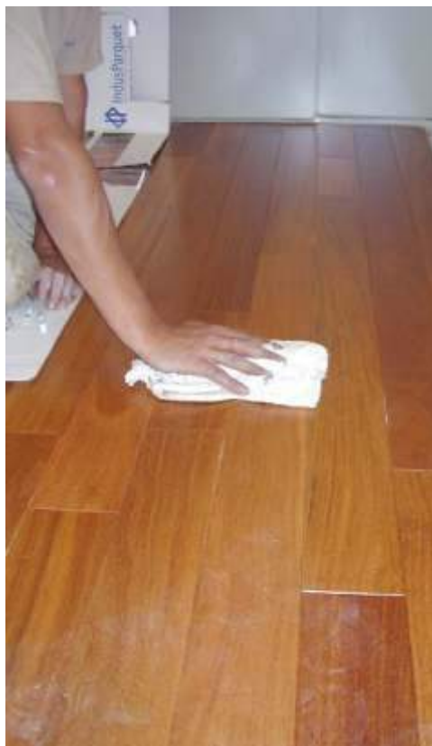
Figura 36. Limpeza do piso após instalação.
