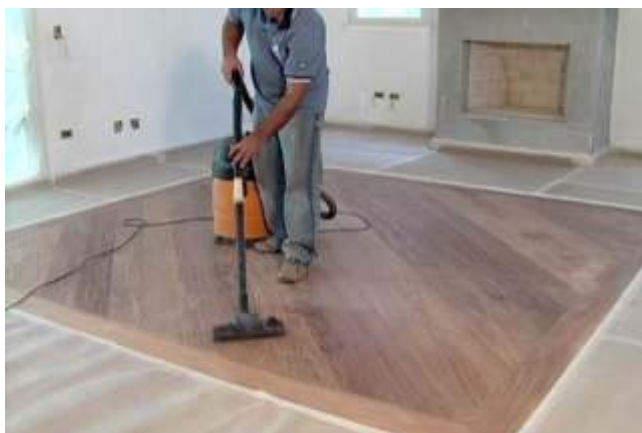
Figura 45. Limpeza do piso com aspirador de pó.
