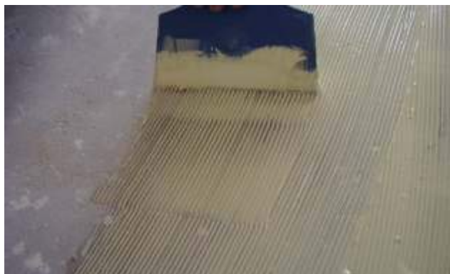
Figura 25. Aplicação de adesivo PU.
