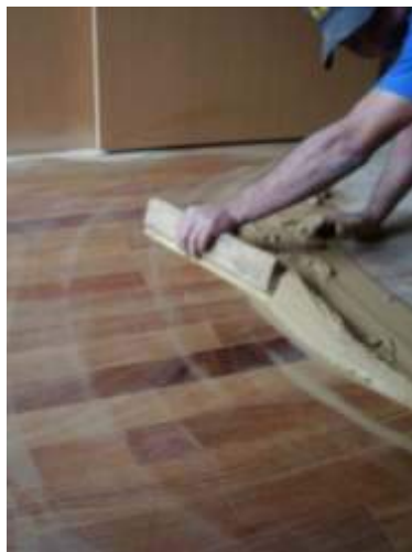
Figura 44. Calafetação do piso com massa preparada com cola branca.
