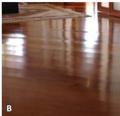
Figura 59. Problemas causados pela absorção de umidade.
