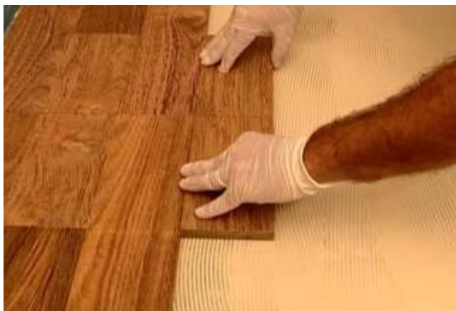
Figura 34. Montagem e fixação do piso de madeira utilizando adesivo.
