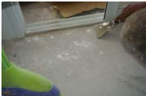
Figura 27. Limpeza com espátula de metal.
