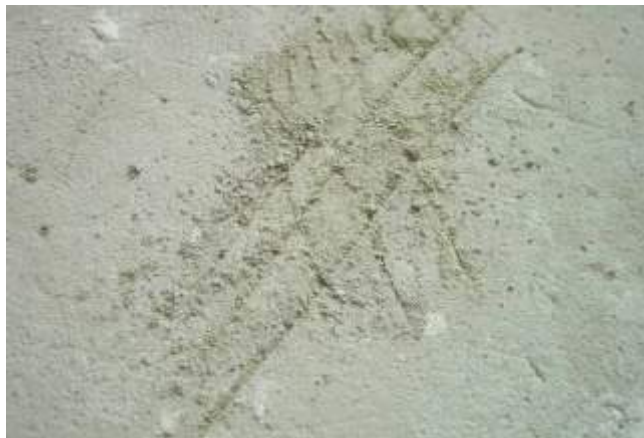
Figura 20. Teste de resistência do contrapiso utilizando riscos com prego.
