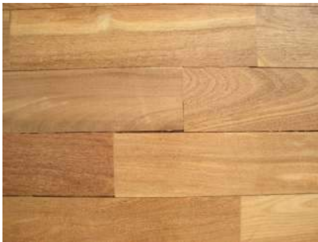
Figura 54. Frestas em decorrência da variação na largura das régua.
