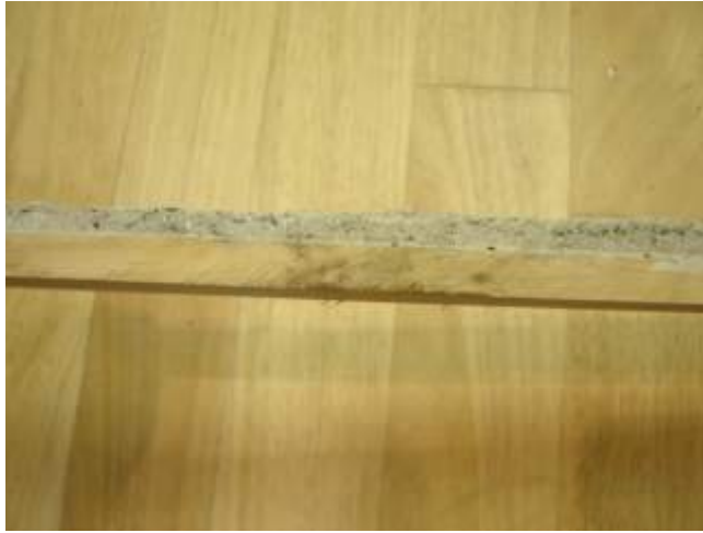
Figura 60. Camada de regularização sem aderência à base.
