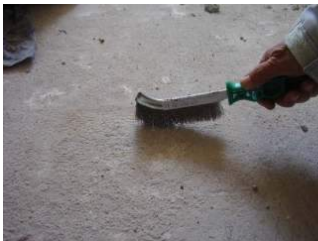
Figura 21. Teste de resistência do contrapiso utilizando escova de aço.
