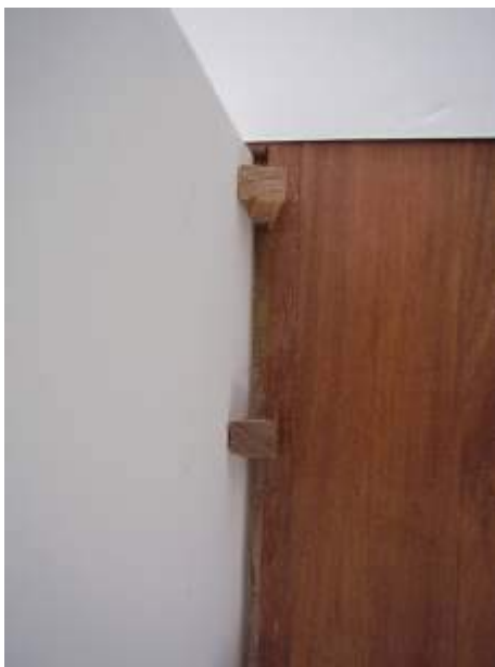
Figura 39. Juntas de dilatação.
