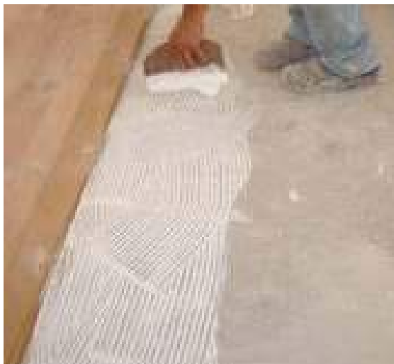
Figura 24. Aplicação de adesivo PVA.
