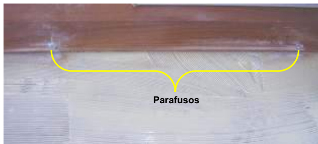
Figura 35. Montagem e fixação do piso de madeira utilizando adesivo e parafuso.
