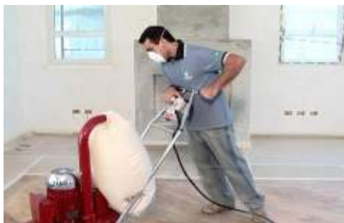
Figura 42. Lixamento do piso.
