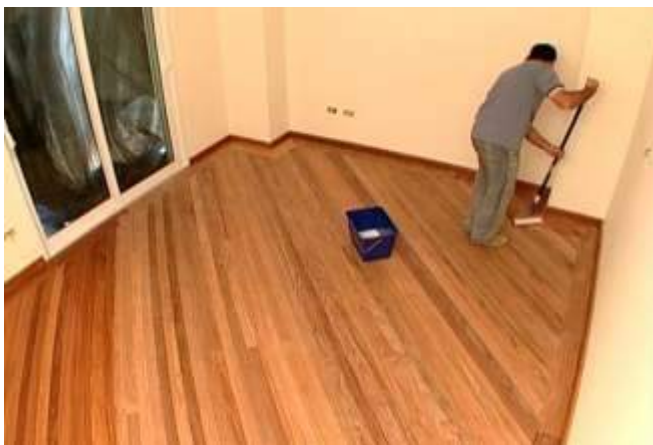
Figura 47. Aplicação de selador.
