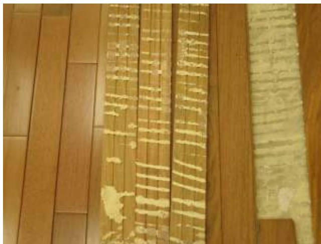
Figura 62. Má distribuição do adesivo na régua.
