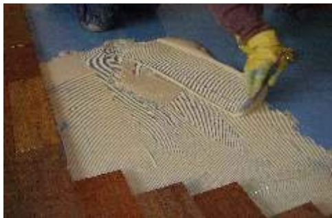
Figura 31. Aplicação de adesivo.
