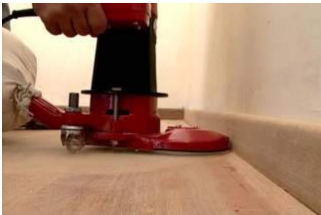
Figura 43. Lixamento dos cantos.
