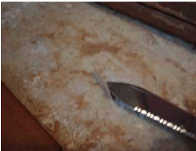
Figura 61. Adesivo aplicado em pequena quantidade.
