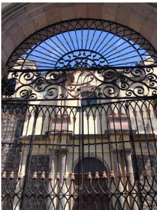
33. Reja de acceso en el templo de la Merced, en hierro y plomos, de cuatro hojas y cinco cuerpos con elementos varios: medallón de caligrafía, cabezal con soleras, abanico.
