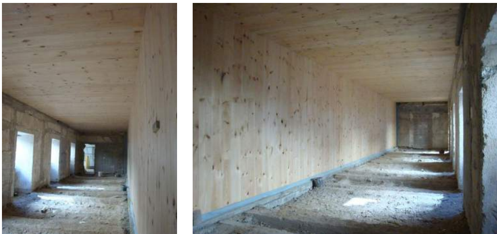
Figura 8 – Reabilitação de edifício.
