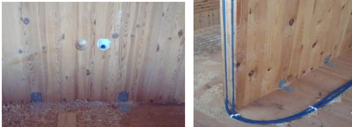
Figura 6 – Instalações elétricas em paredes com face à vista.
