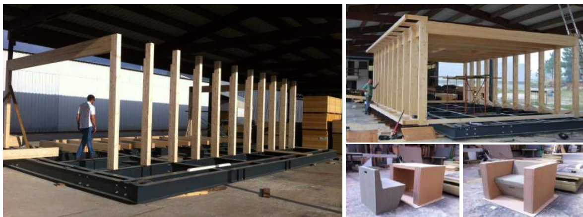
Figura 23 – Fotos da construção do protótipo em Viana.
