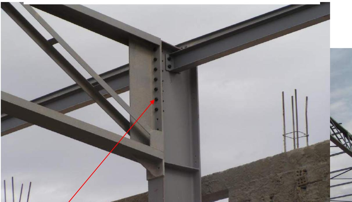
Montage de la ferme liaison complète : fixation par boulons HR
