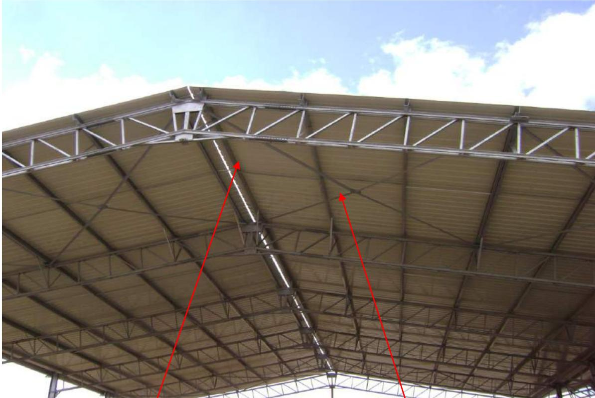
Montage de la couverture en tôle ondulé
