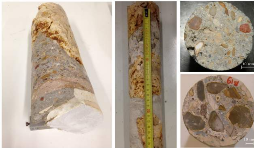
Figure 2.8 – Matériaux constitutifs des tunnels du métro parisien : carottes extraites de la voûte, éprouvettes de mortier et de béton.
