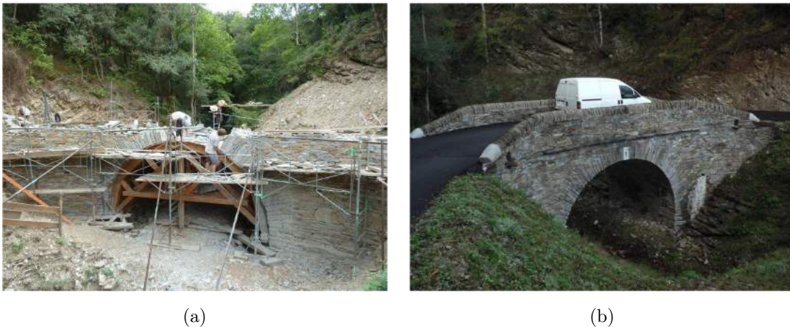
Figure 4.2 – Construction (a) et vue du pont en maçonnerie de Chaldecoste en Lozère (b).
