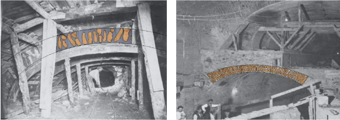
Figure 2.4 – Étude photographique de l'appareillage de la maçonnerie des voûtes du métro parisien.
