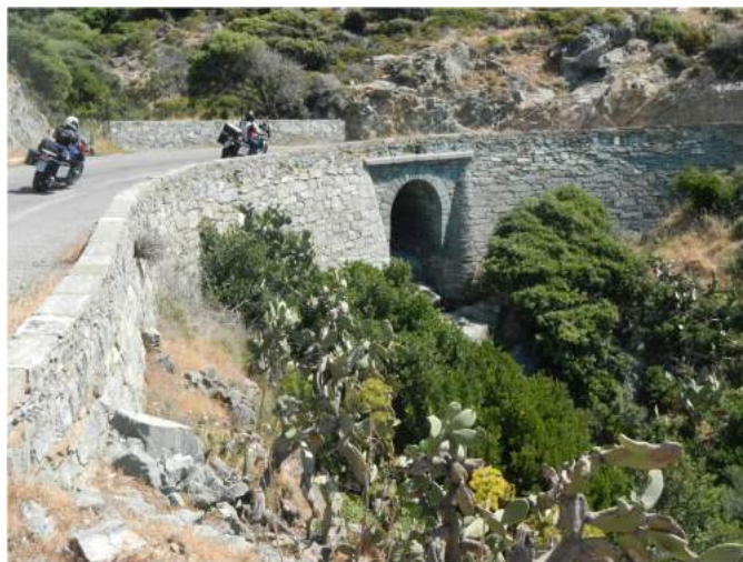
Figure 1.1 – Route aménagée par des murs en pierre sèche au Cap Corse (Haute-Corse).
