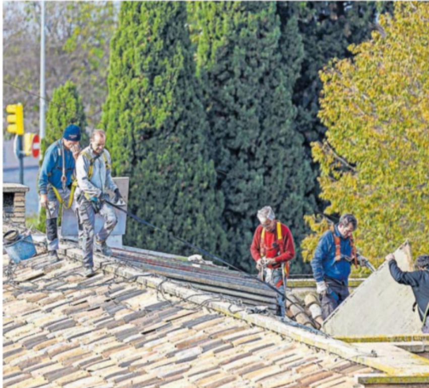
Varios operarios trabajaban en un tejado en Zaragoza el martes. JAVIER BELVER (EFE)
