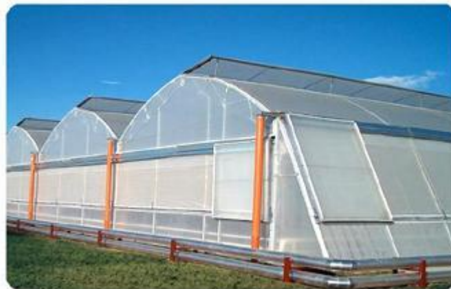
Figura 3. Invernadero en forma de Túnel
