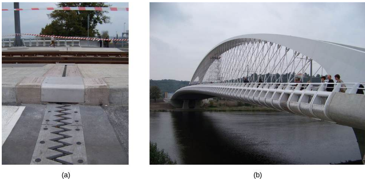
FIGURA 1.5 (a) Las juntas de dilatación térmica como estas en el (b) puente del puerto de Auckland, en Nueva Zelanda, permiten que los puentes cambien de longitud sin pandearse (créditos: modificación de trabajos de "ŠJŮ"/Wikimedia Commons).
