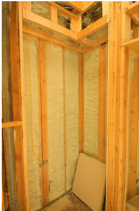
FIGURA 1.20 El aislamiento sirve para limitar la conducción del calor del interior al exterior (en invierno) y del exterior al interior (en verano) (créditos: Giles Douglas).
