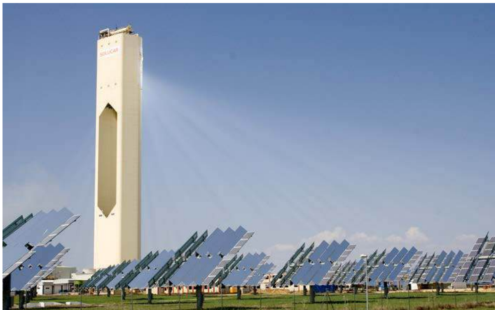
Fazenda solar, com os painéis solares de captação focados para a torre (Local: Andaluzia, Espanha)
