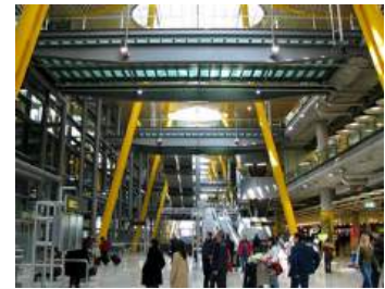
Aeropuerto de Barajas
