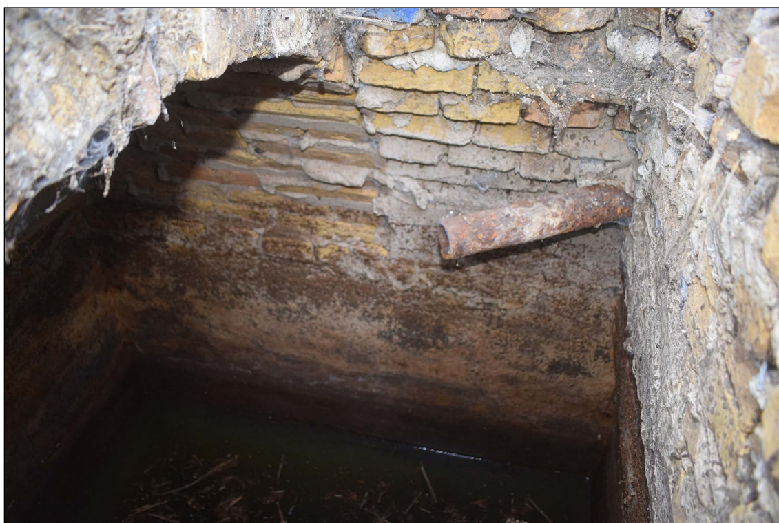
Afb. 127. Een ijzeren buis bovenin de noordwesthoek van de kelder.
