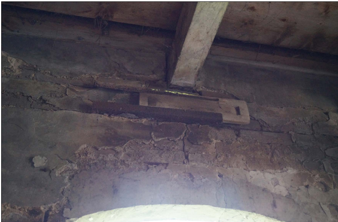
Afb. 26. Een rooster boven een stalraam, met schuif om het dicht te zetten.
