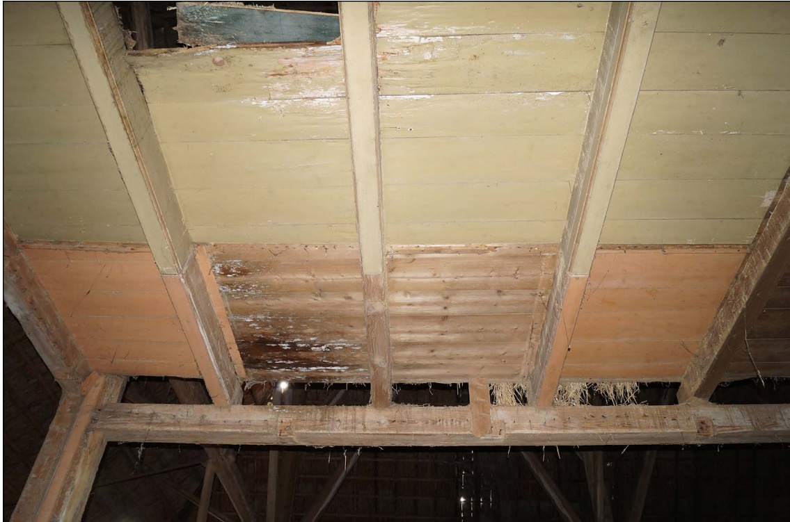
Afb. 47. Detail van het plafond in het onverwarmde woonvertrek. Ter plaatse van het onbeschilderde deel bevond zich een bedstede, links en rechts hiervan (geel geverfd) zaten kasten.
