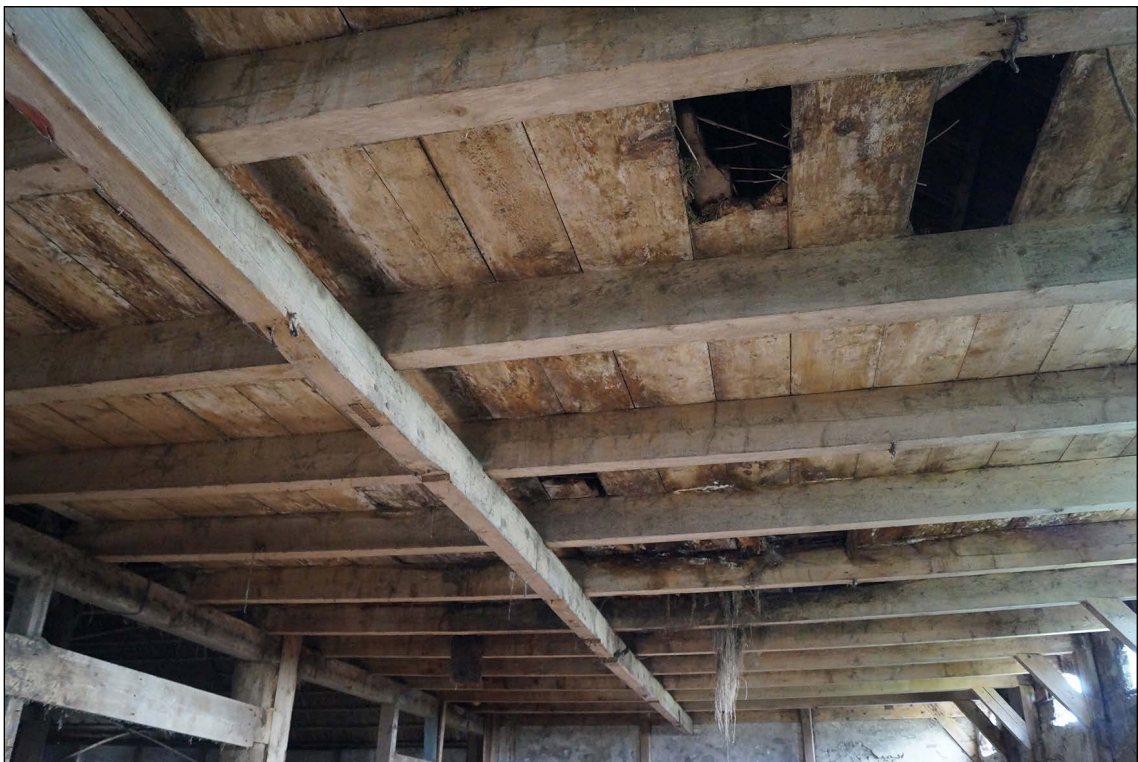
Afb. 49. Onderslagbalk onder de zolderbalken van de koeienstal.
