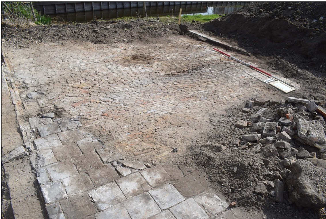
Afb. 132. Bestrating in de zuidoosthoek van de lage aanbouw achter de boerderij. Op de bakstenen hebben grijze plavuizen (blauwbakken) gelegen.
