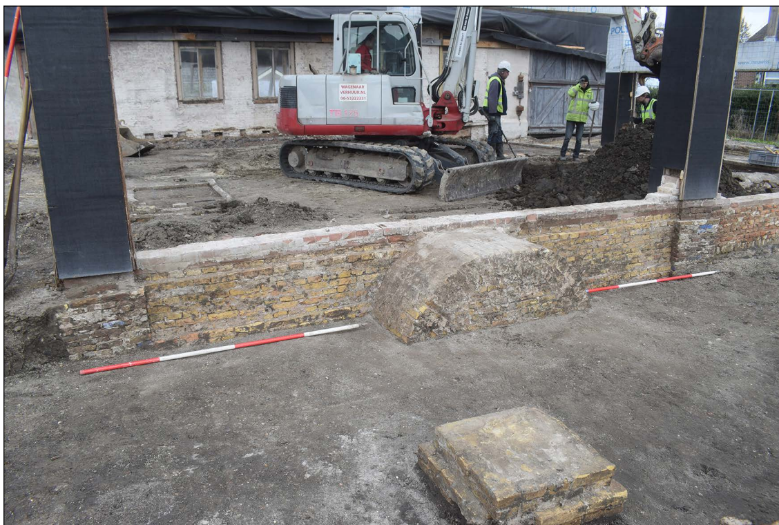
Afb. 118. Muur S13 met waterkelder S1.
