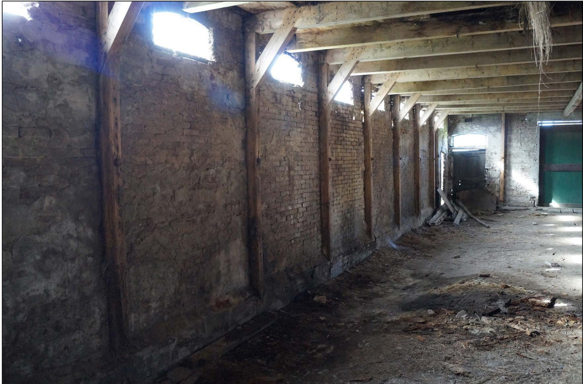
Afb. 48. De binnenzijde van de achtergevel. De muurstijlen tegen de gevel zijn verbonden met de zolderbalken. Deze verbinding is versterkt met korbelen.
