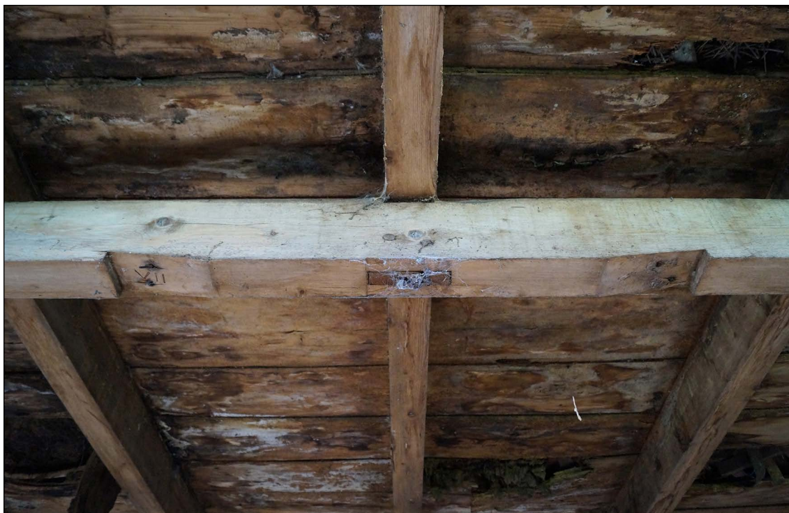
Afb. 50. In het midden een pengat van een koestijl in een onderslagbalk. Links en rechts daarvan een tand van korbelen die de verbinding tussen de zolderbalken en onderslagbalk vormde.
