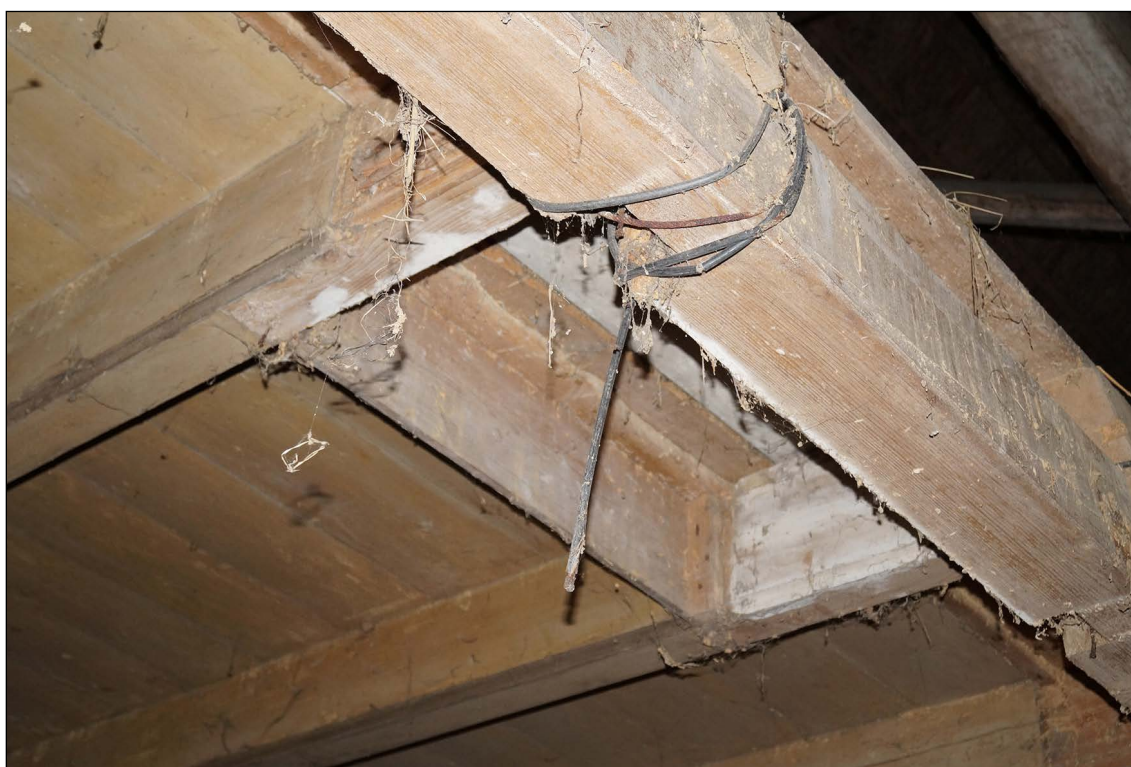
Afb. 42. Plank van de haard haaks op de zolderbalken.
