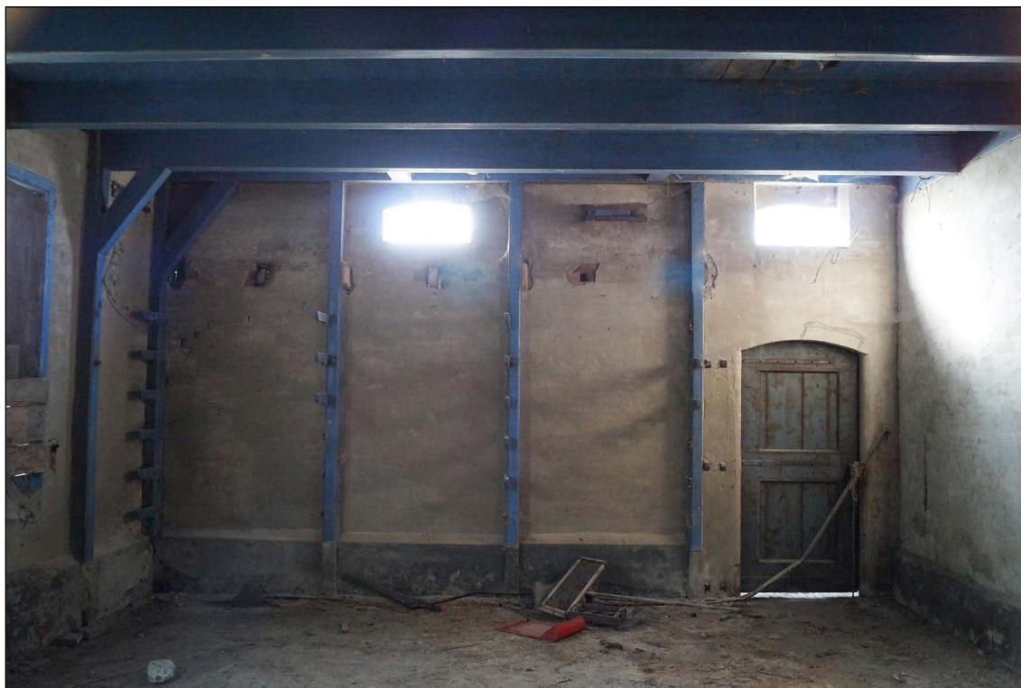
Afb. 38. De zuidmuur in de kaasmakerij, met stijlen met dragers voor de kaasplanken.
