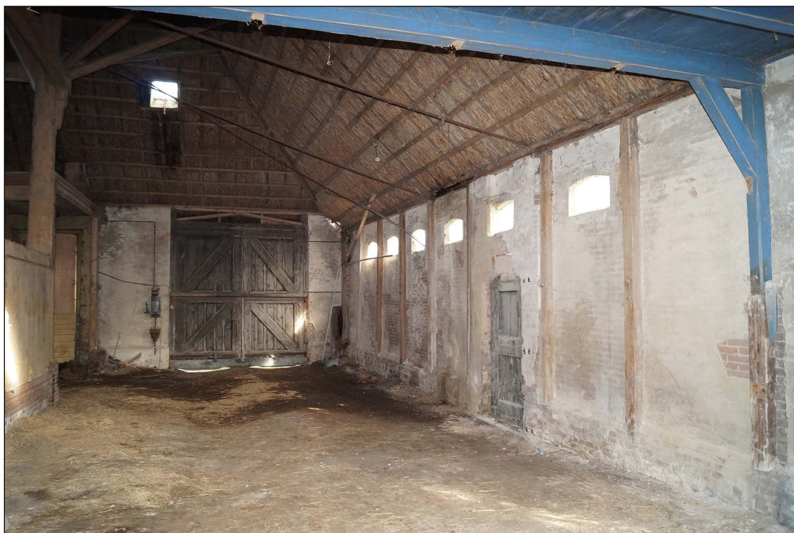
Afb. 31. De dars gezien richting de voorgevel in 2014.
