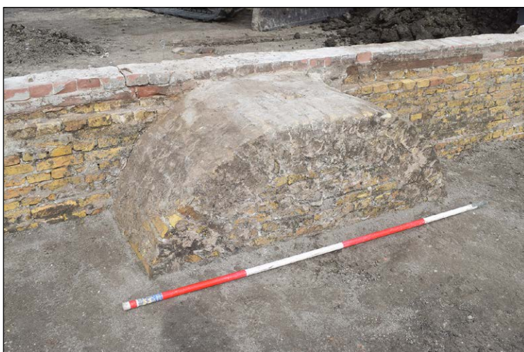
Afb. 126. Regenwaterkelder S1, gezien vanaf twee zijden.
