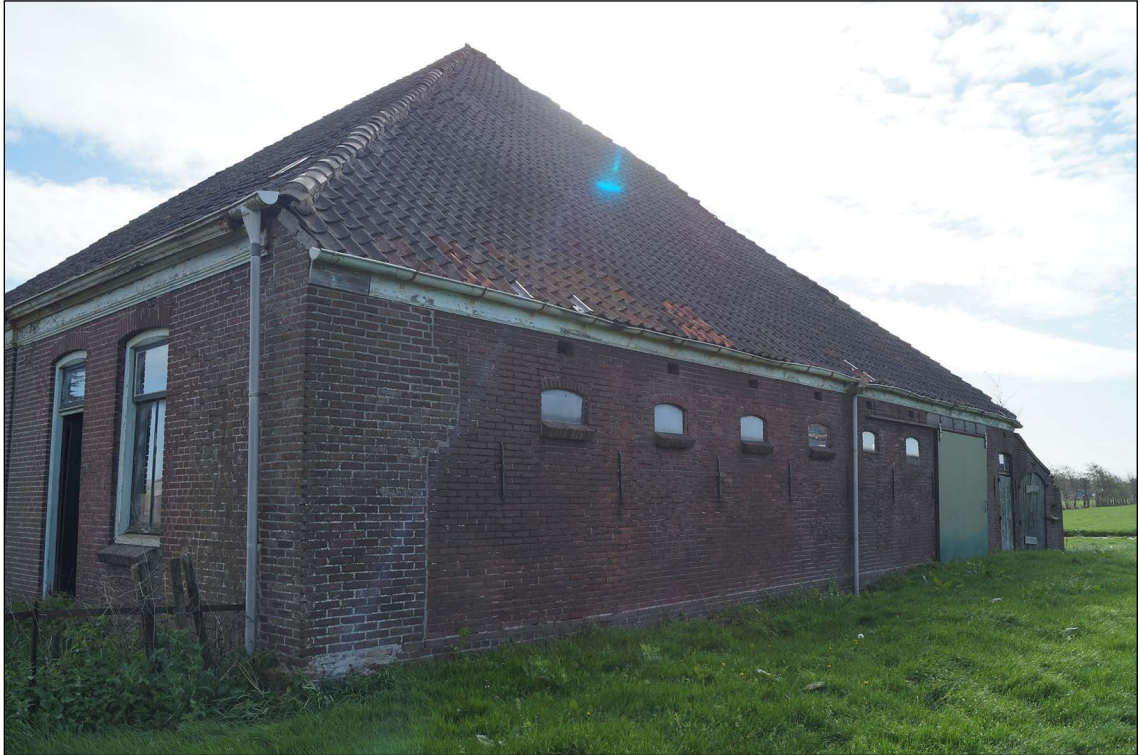
Afb. 27. De westelijke zijgevel, met een nieuw stuk muurwerk bij de voorgevel.
