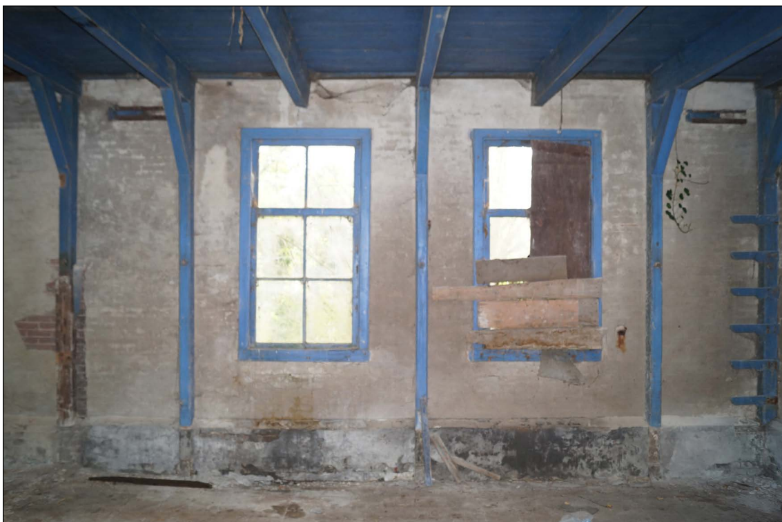
Afb. 41. De oostmuur van de kaasmakerij, met ramen en muurstijlen.
