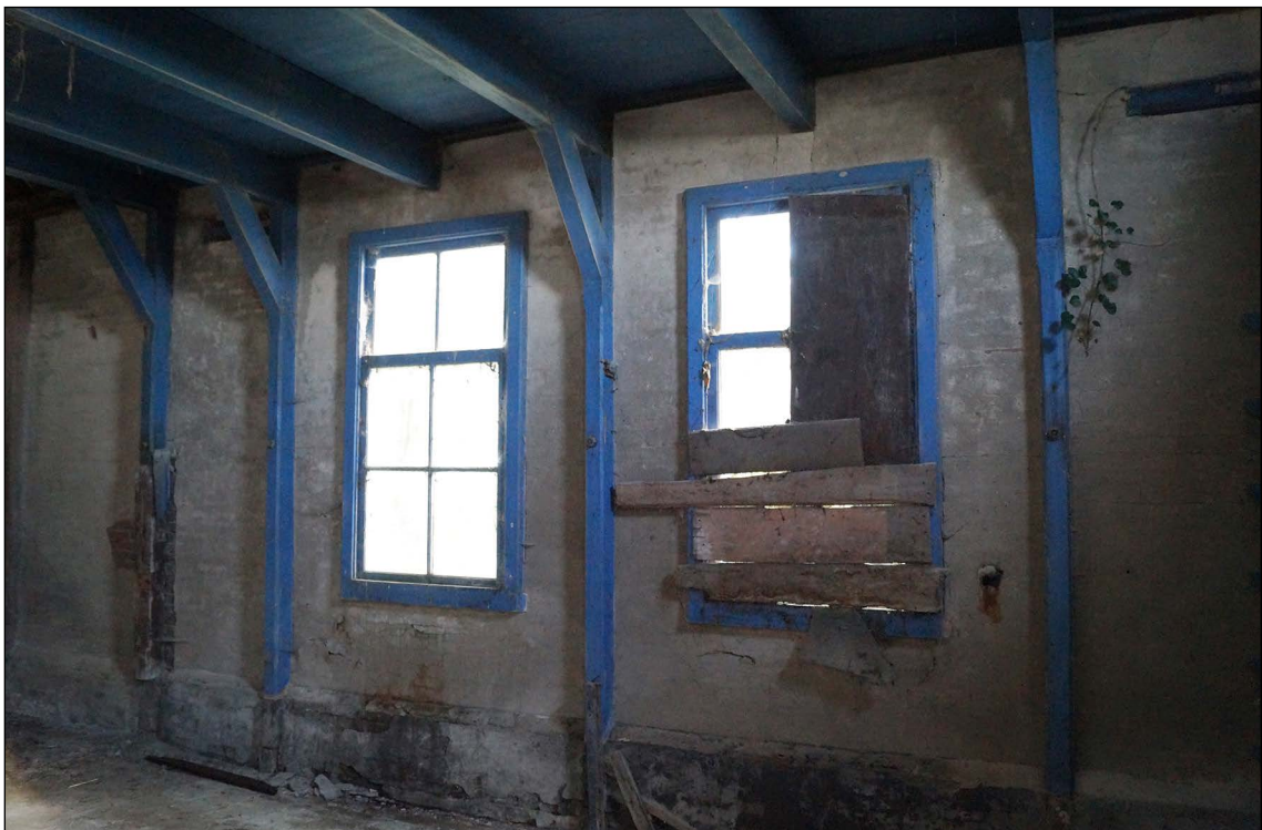
Afb. 28. De ramen in de oostelijke zijgevel in 2014, in de kaasmakerij.
