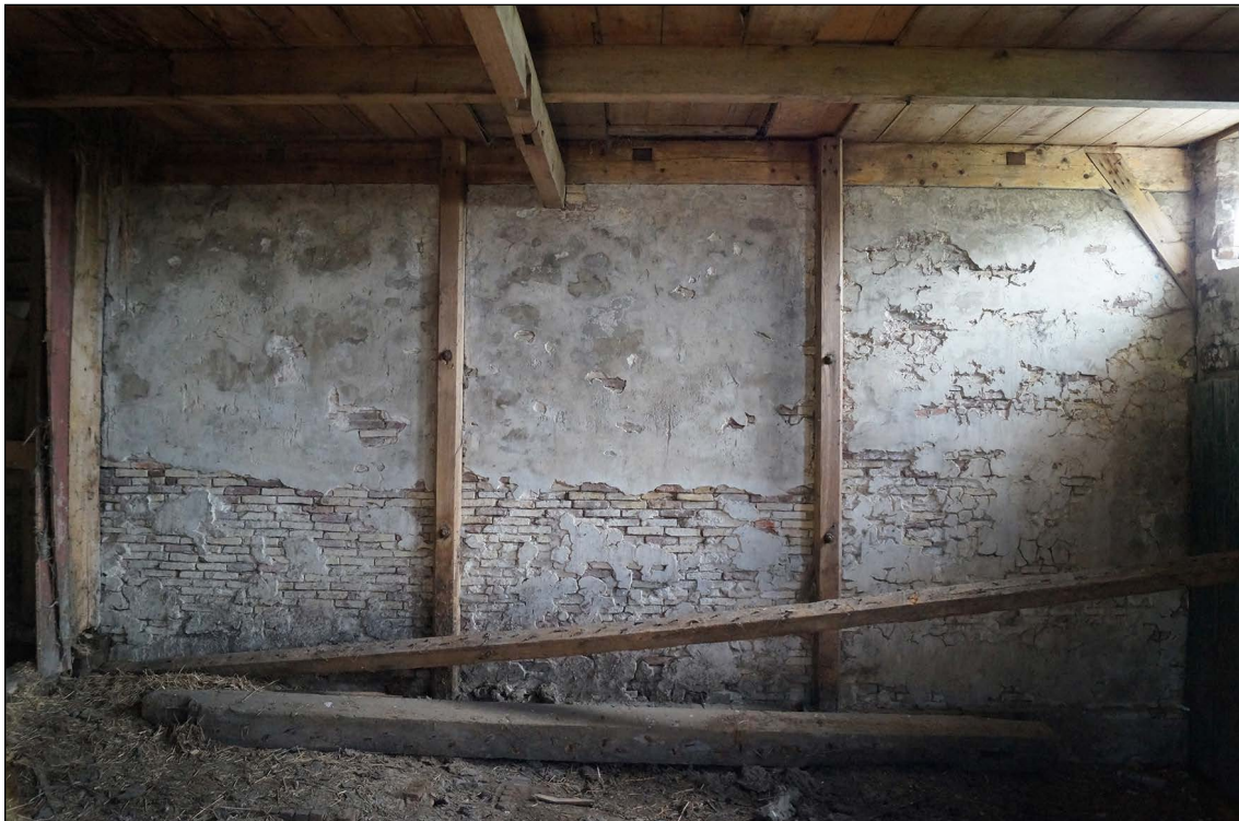
Afb. 40. De bakstenen muur tussen de kaasmakerij en koeienstal, gezien vanuit de koeienstal.
