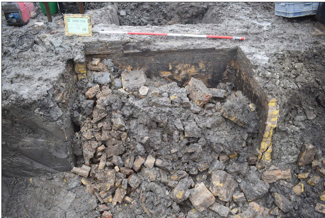
Afb. 97. De puinvulling in regenwaterkelder S7.
