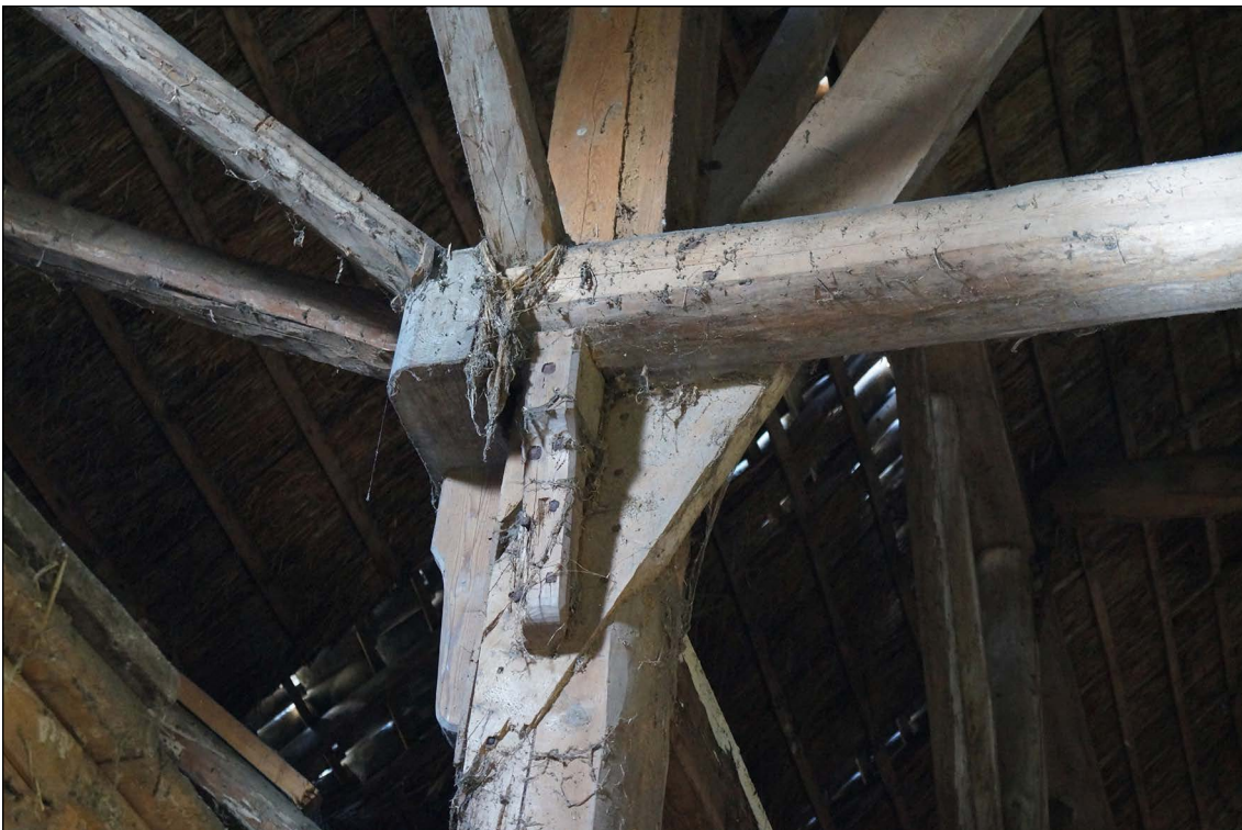
Afb. 55. Detail van een vierkantstijl met zwing en jaagbanden.
