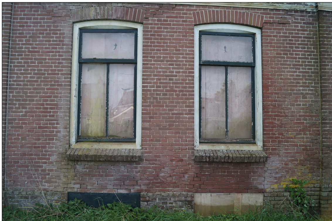
Afb. 22. De ramen van het onverwarmde woonvertrek met daaronder kelderramen.
