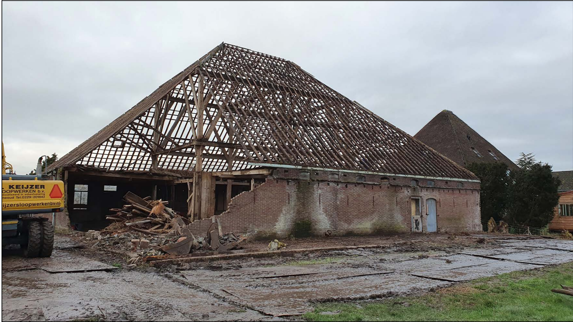
Afb. 23. De achtergevel van de boerderij in 2019. De lage aanbouw tegen de achtergevel is gesloopt.
