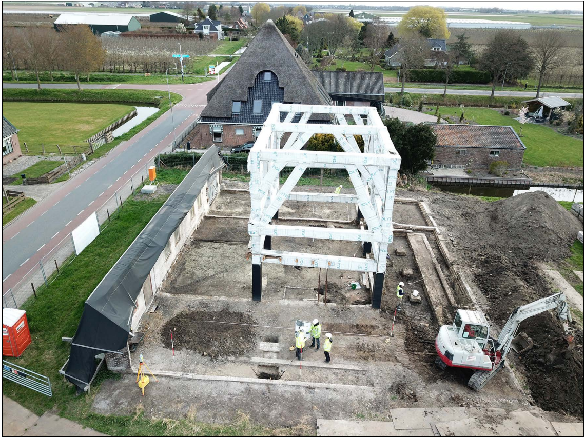
Afb. 4. De opgraving in volle gang. In het midden het ingepakte vierkant, links de gestutte voorgevel. Foto: Hans van Poelje.
