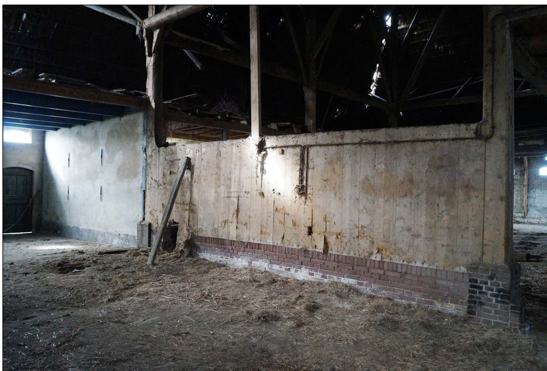
Afb. 33. De houten wand tussen de dars en hooiberg. Links de muur tussen de kaasmakerij en stal.
