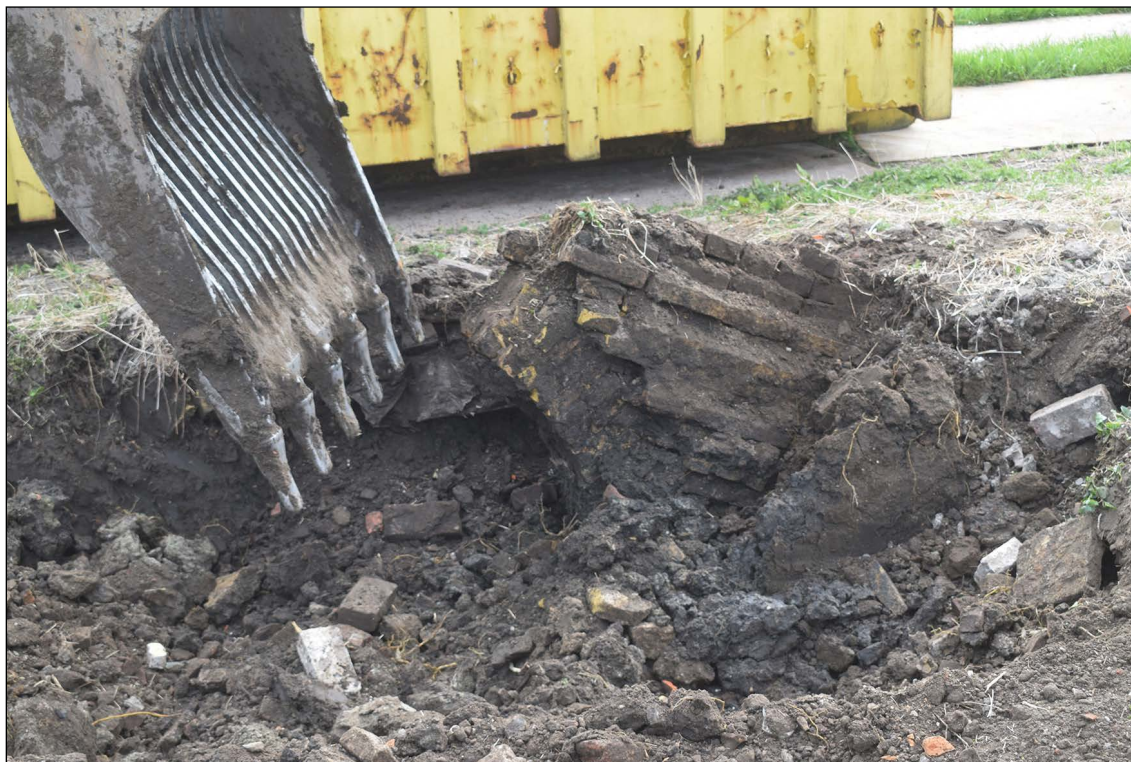
Afb. 134. Een spaarboogfundering in de achtergevel van de lage aanbouw.
