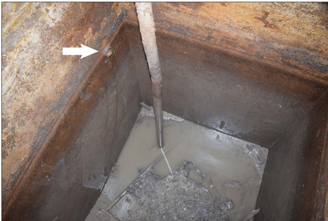
Afb. 128. Ijzeren buis onderin de zuidoosthoek van de kelder (bij de pijl). Er bevindt zich verder een verticale pompbuis in de put.
