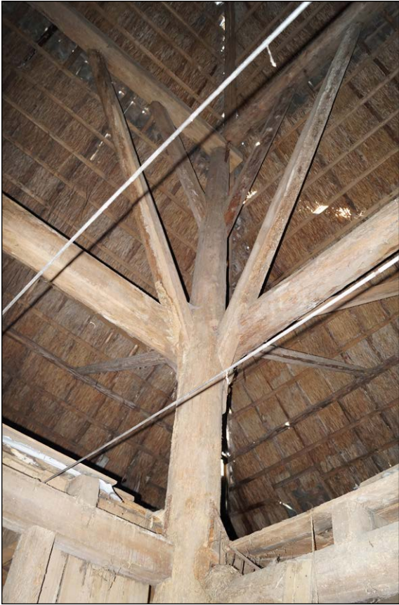
Afb. 54. Detail van een vierkantstijl.
