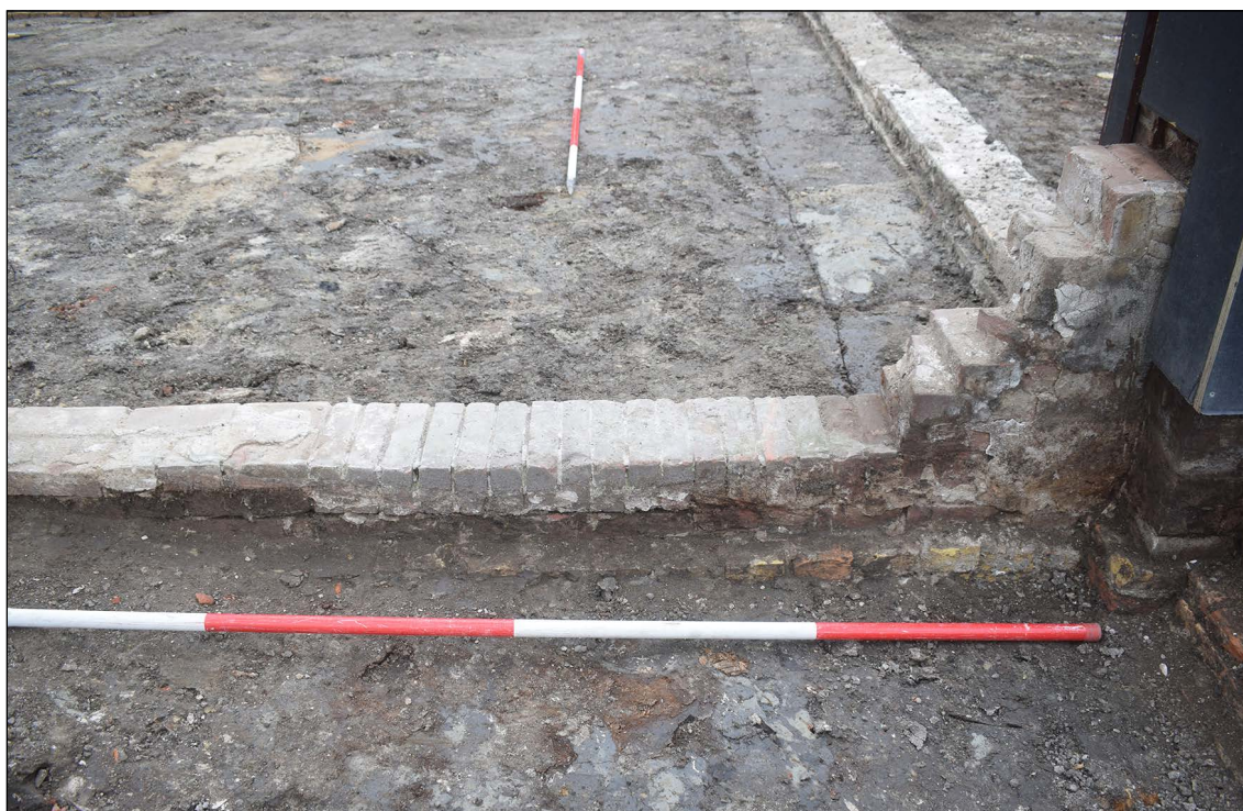
Afb. 119. Detail van muur S25: op de plek van een deur is de muur lager uitgevoerd en de bovenkant voorzien van een rollaag.
