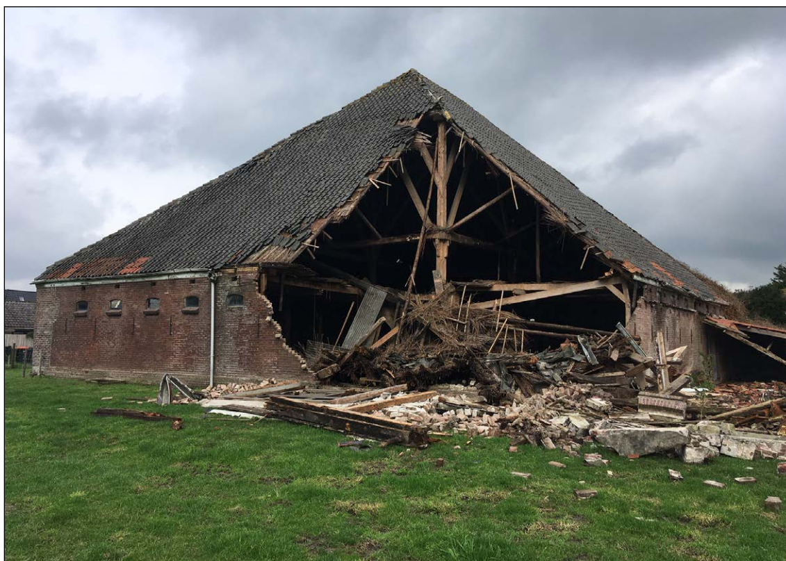
Afb. 17. De achterkant van de stolpboerderij in oktober 2019.
