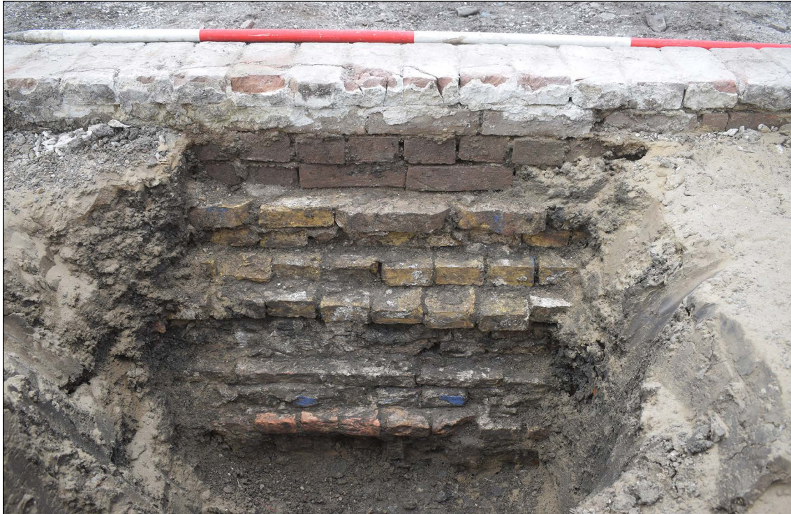
Afb. 114. De opbouw van fundering S42 van de westelijke zijgevel.
