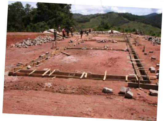
Réalisation des fondations du bâtiment, Madagascar.
