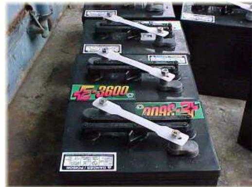
**Importante:** para evitar la aparición de chipas en los bornes de la batería, siempre se conectarán los cables en vacío, es decir, libres en el extremo del regulador
