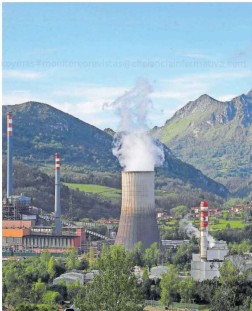
Central térmica de Soto de Ribera, en las proximidades de Oviedo. J. L. CERREJIDO (EFE)
