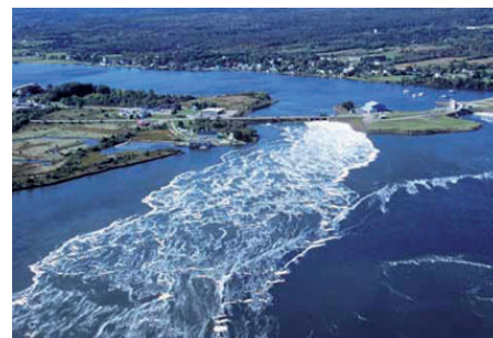
Figura 2.31. Intensas corrientes de marea son observadas diariamente en la bahía de Fundy, Canadá. Estas condiciones son ideales para la extracción de energía renovable denominada mareomotriz.
