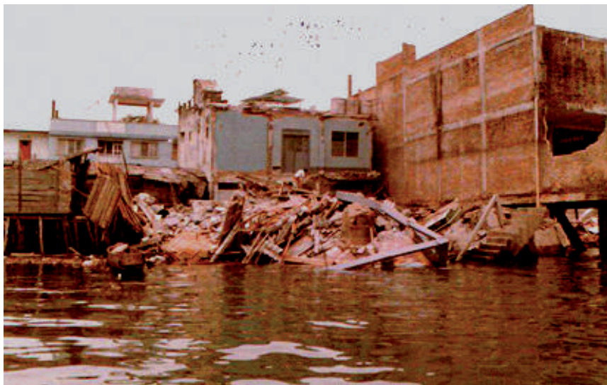
Figura 2.53. Destrucción de viviendas costeras en Tumaco, Colombia, como consecuencia de tres fenómenos: sismo, licuefacción y tsunami de diciembre de 1979. Fuente: Fotografía International Tsunami Information Center , George Paras-Carayannis, 1980.
