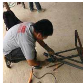
Figura 10. Construcción de la base.
