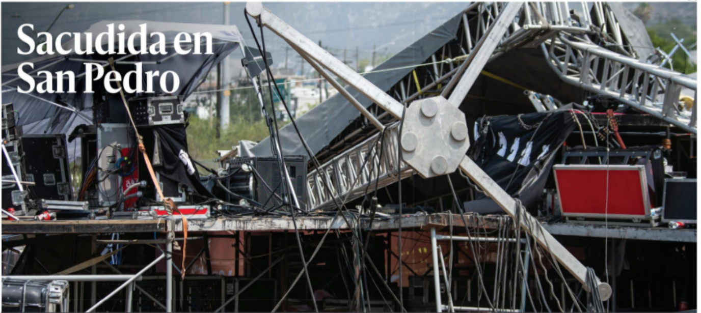
Las estructuras metálicas que soportaban el templete del mitin de Movimiento Ciudadano fueron colapsadas por las ráfagas de viento.
