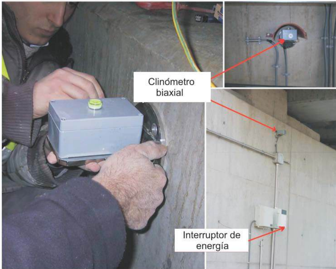
Figura 5.36 Instalación de un clinómetro (cortesía de Sisgeo)
