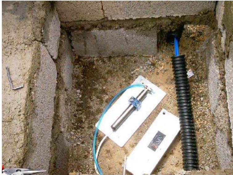
Figura 5.74 Instalación de una celda de asentamiento (cortesía de Sisgeo)
