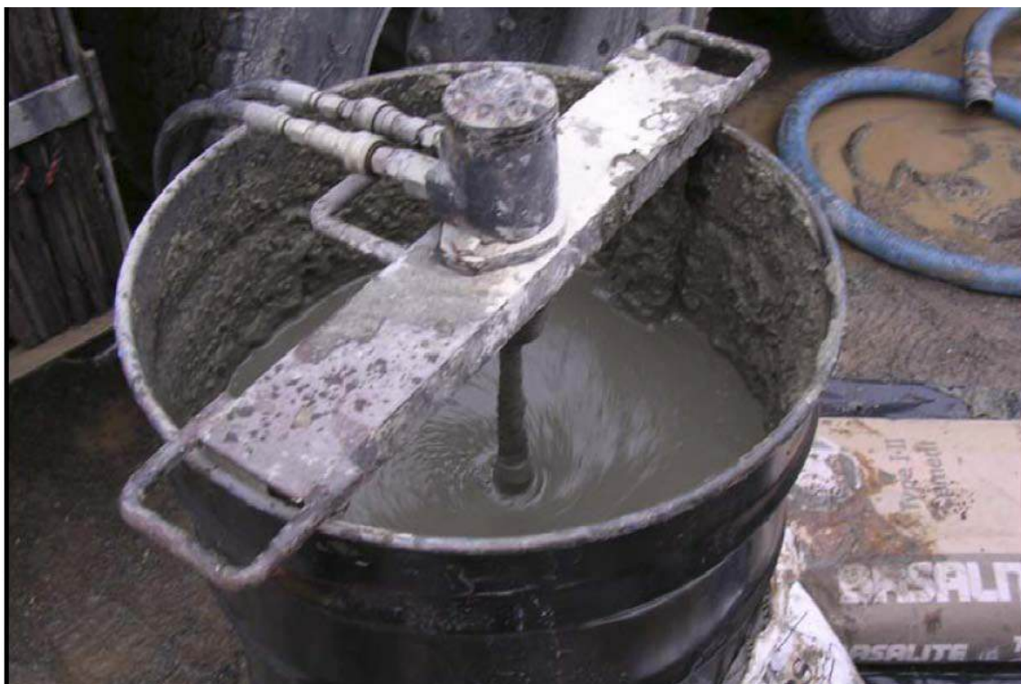
Figura 6.45 Mezclado de cemento-bentonita (Mikkelsen y Green 2003)
