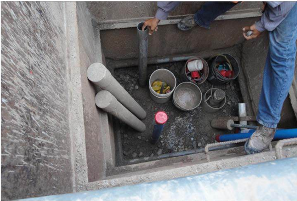
Figura 5.16 Instalación de tubos guía de plástico y de aluminio dentro de una caja metálica de protección durante la construcción de un terraplén
