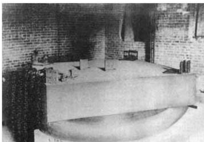
El interferómetro utilizado por Michelson y Morley.
