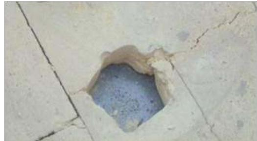
*Perforación realizada en el piso del horno*
