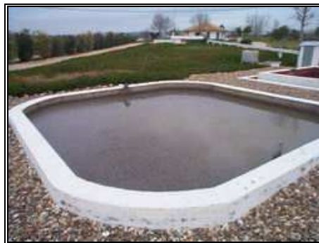
Figura 18. Fotografía de una laguna de depuración.
