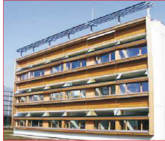
Reflectors at the Laboratoire d'Energie Solaire (LESO) in Lausanne (arch. D. Pagadaniel).
