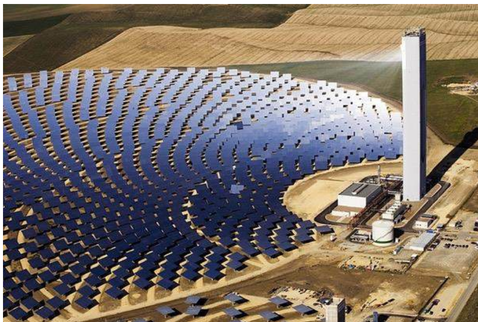
Figura 16: Exemplo de aplicação do concentrador tipo torre, disponível em: < http://blog.is-arquitectura.es/2014/11/09/nuevo-nanomaterial-hace-mas-eficientes-plantas-energia-termica-concentrada/ >. Acesso em 02/06/2016.
