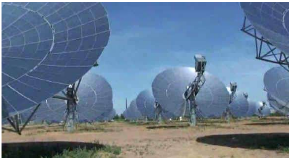
Figura 14: Usina solar térmica utilizando coletores parabólicos, disponível em: < http://outilssolaires.com/developpement-durable/energie-solaire/capteurs-paraboliques+a154.html >. Acesso em 02/06/2016.
