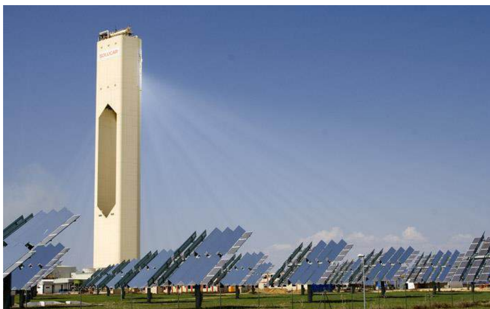
Figura 17: Detalhe do elemento concentrador do tipo torre, disponível em: < https://pt.wikipedia.org/wiki/Energia_heliot%C3%A9rica >, acesso em 02/06/2016.
