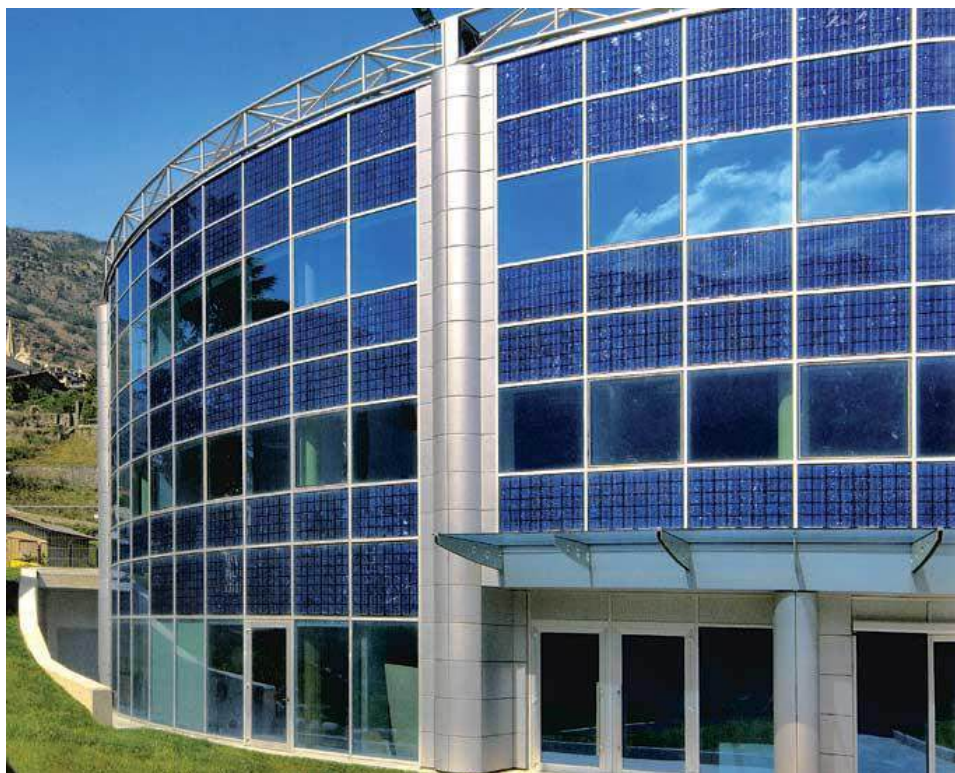
Figura 20: Placa fotovoltaica integrada a fachada da instalação, disponível em: < http://www.pensamentoverde.com.br/sustentabilidade/como-funciona-energia-solar-e-quais-suas-vantagens-e-desvantagens/ >. Acesso em 02/06/2016.
