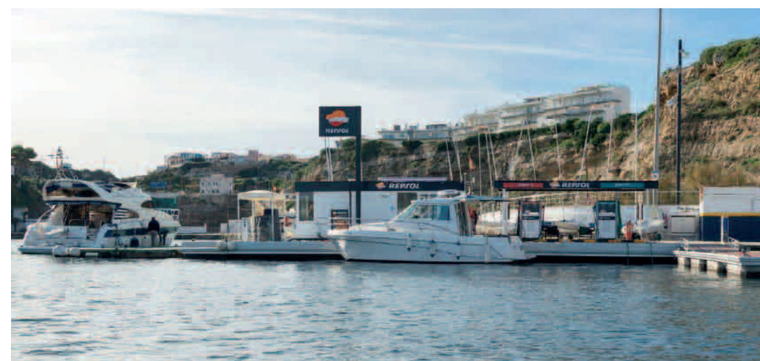
Gasolinera Club Marítimo, estado actual.
