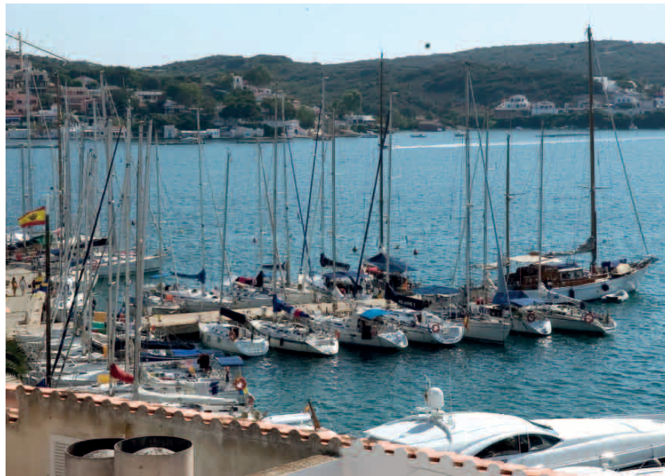
Primer pantalán hormigón.
