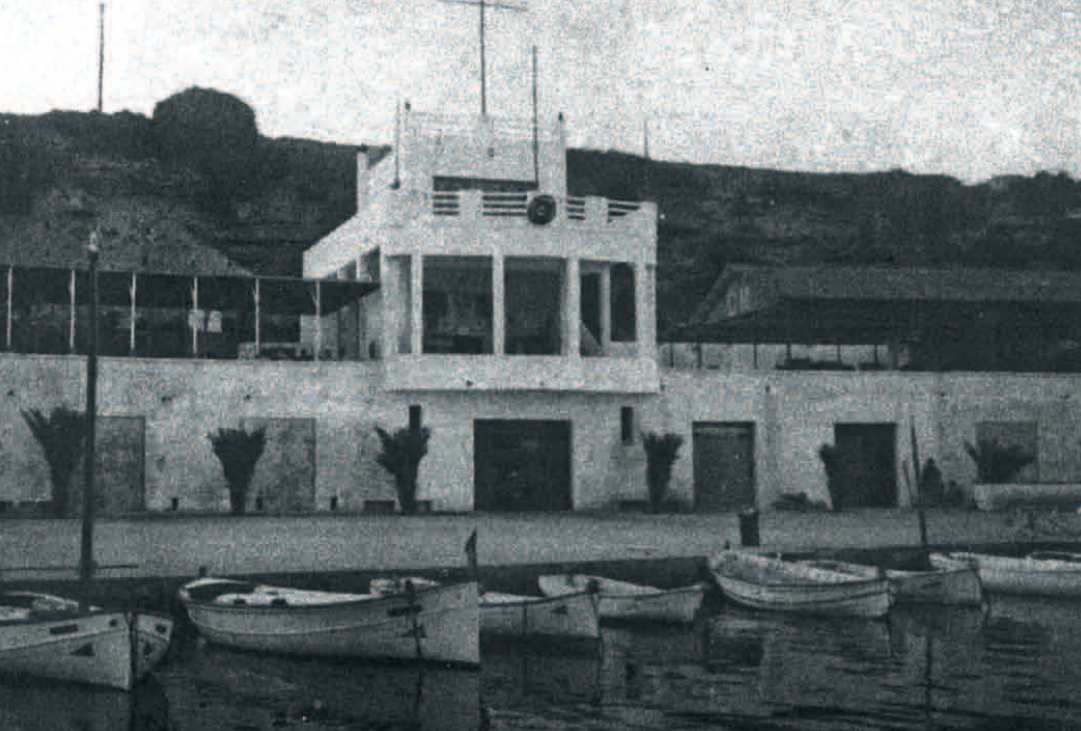
Las obras de ampliación y contención fueron una constante a lo largo de los años.
