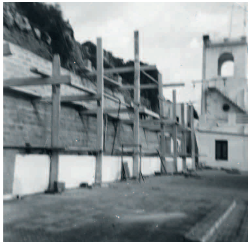
Muro de contención en el ala sur , construido por D. Basilio y D. Francisco Ferrer.
