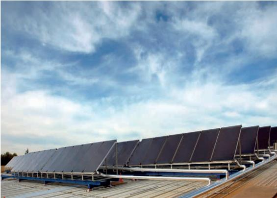
**Figura 2.** Instalación deportiva en Móstoles resuelta con sistemas Drain Back (340 m<sup>2</sup> de superficie de captación).
