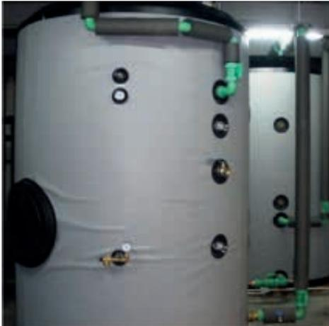
**Foto 8.7.** Sistema de acumulación del agua caliente industrial.
