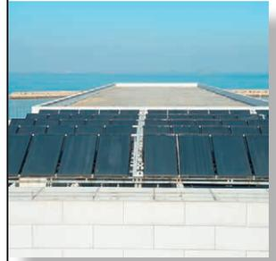
Cuando la temperatura de los paneles sea mayor que la que se tiene en la parte de abajo del depósito, eso significa que en los paneles solares hay suficiente energía como para calentar el depósito. Normalmente se encenderá la bomba cuando los paneles solares están unos 7 K por encima de la temperatura del depósito y se desconectará cuando esta diferencia se reduzca por debajo de los 3 o 4 K.
