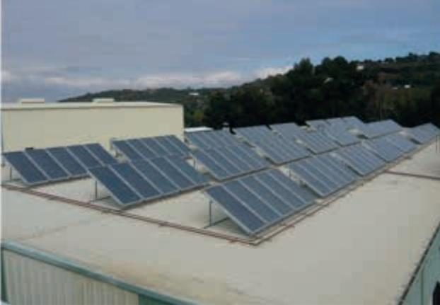
**Foto 8.6.** Campo de colectores solares (252 m<sup>2</sup>) en sector alimentación.
