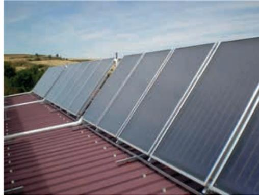
**Foto 8.8.** Campo de colectores solares (525 m<sup>2</sup>) en industria química.
