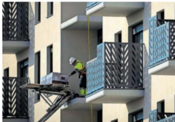
Construcción de un bloque de viviendas en Madrid. JUAN BARBOSA
