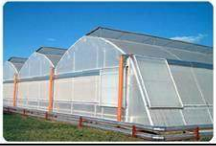
Figura 3. Invernadero en forma de Túnel
