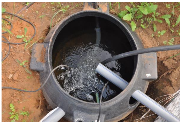
FIGURA 4.47 Tanque coletor sump enterrado no solo para coletar a água por gravidade
