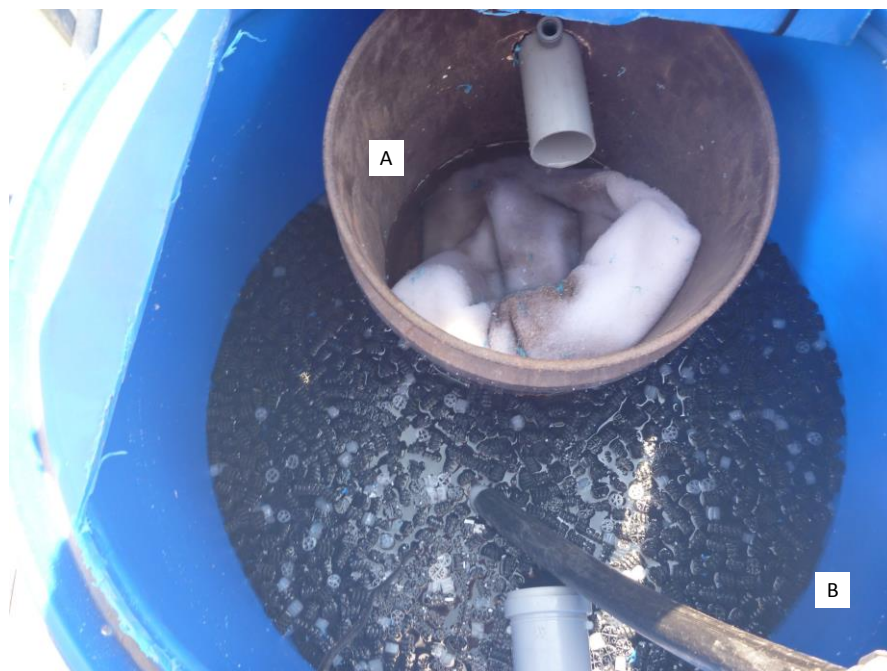
FIGURA 4.30 Detalhes do biofiltro mostrando a (A) filtração mecânica adicional e (B) a mídia utilizada no biofiltro
