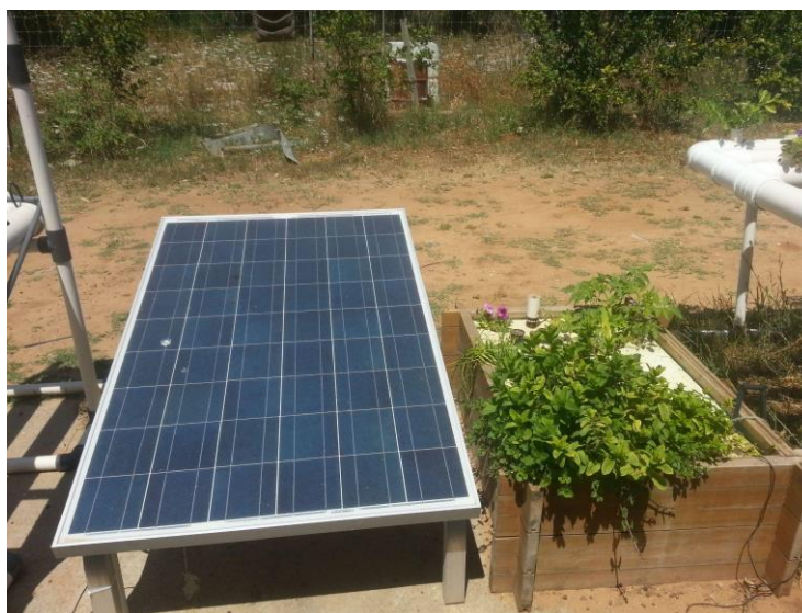
FIGURA 9.10 Células fotovoltaicas usadas para alimentar uma bomba d'água
